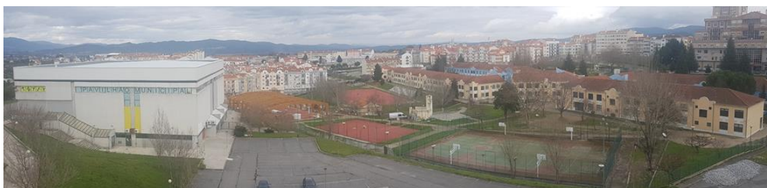
Figura 1. - Pavilhão e Espaços Exteriores da Escola
