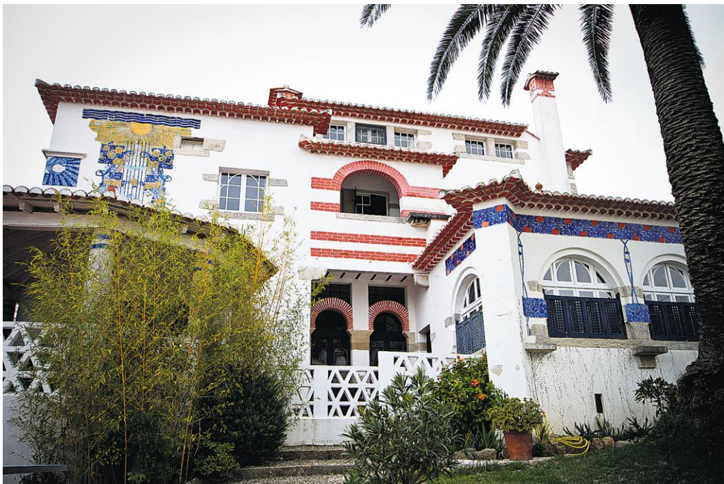
Figura 38 - Casa Monsalvat de Raul Lino, 1901
