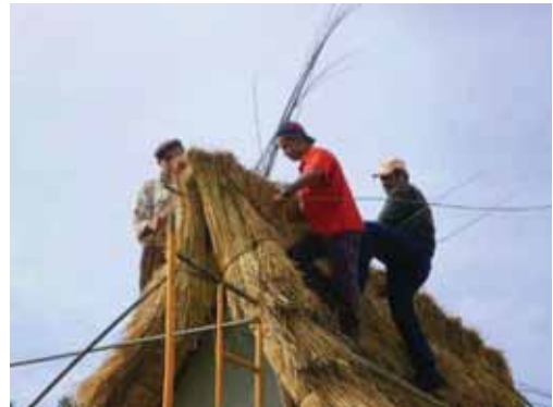
Fig.148 | Vimes fixam as varas à estrutura
