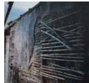
Fig.94 | Parede de tabique
