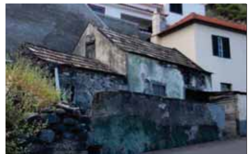
Fig.120 | Casa elementar de duas empenas Maçapez – Porto da Cruz (habitada)
