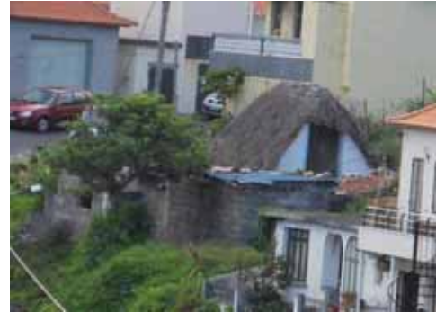
Fig.107 | Casa elementar com cozinha encostada Machico (habitada)
