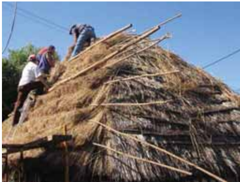
Fig.147 | Colocação das varas
