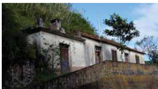
Fig.119 | Casa elementar de cobertura de cerâmica Terra batista – Porto da Cruz (abandonada)
