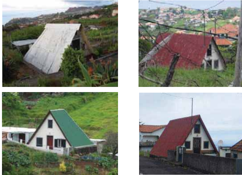
Fig.144 | Telhado substituído por zinco, Santana
