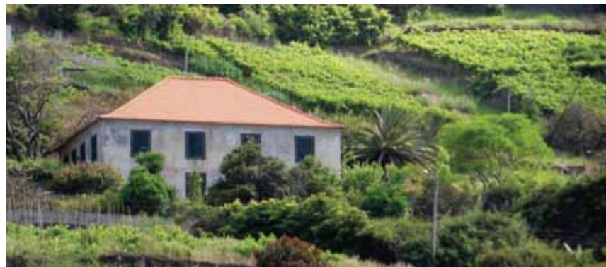
Fig.128 | Casa Complexa de cobertura de telha – telha já substituída
