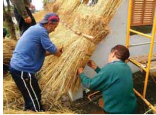
Fig.146 | Colocação da primeira camada de colmo
