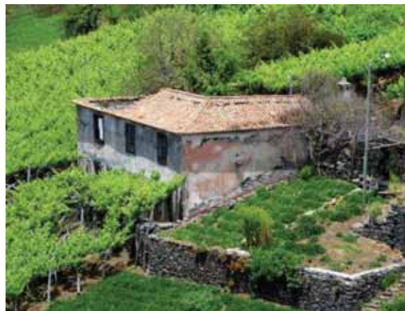
Fig.124 | Casa em esquadria Sítio do Carmo – Campanário (abandonada)
