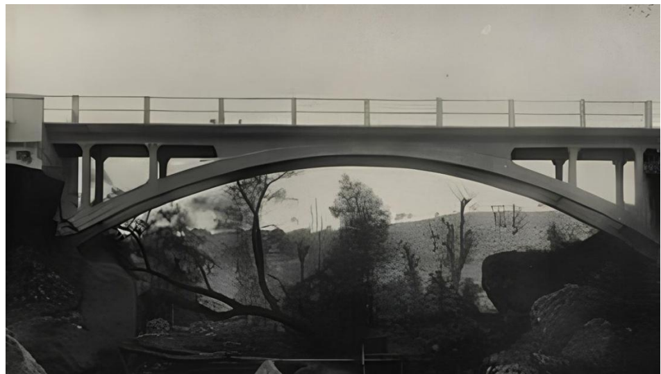
Figura 17| Primeira Ponte de Betão Armado em Portugal (Vieira, s.d.)
