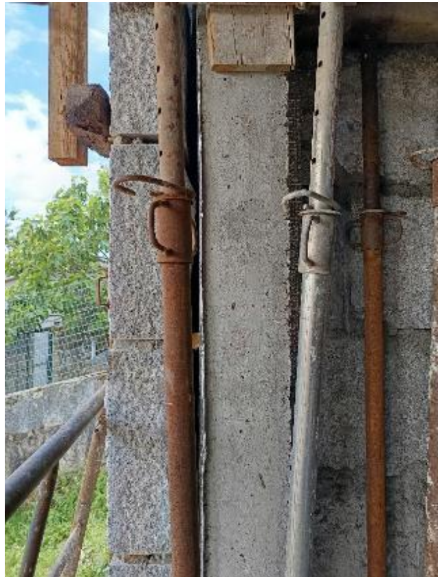
Figura 102| Parede mista com granito e tijolo (Autora,2024)
