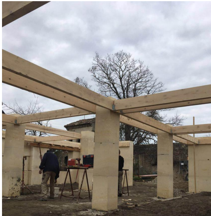
Figura 62| Estrutura (Atelier d'Architecture Perraudin)
