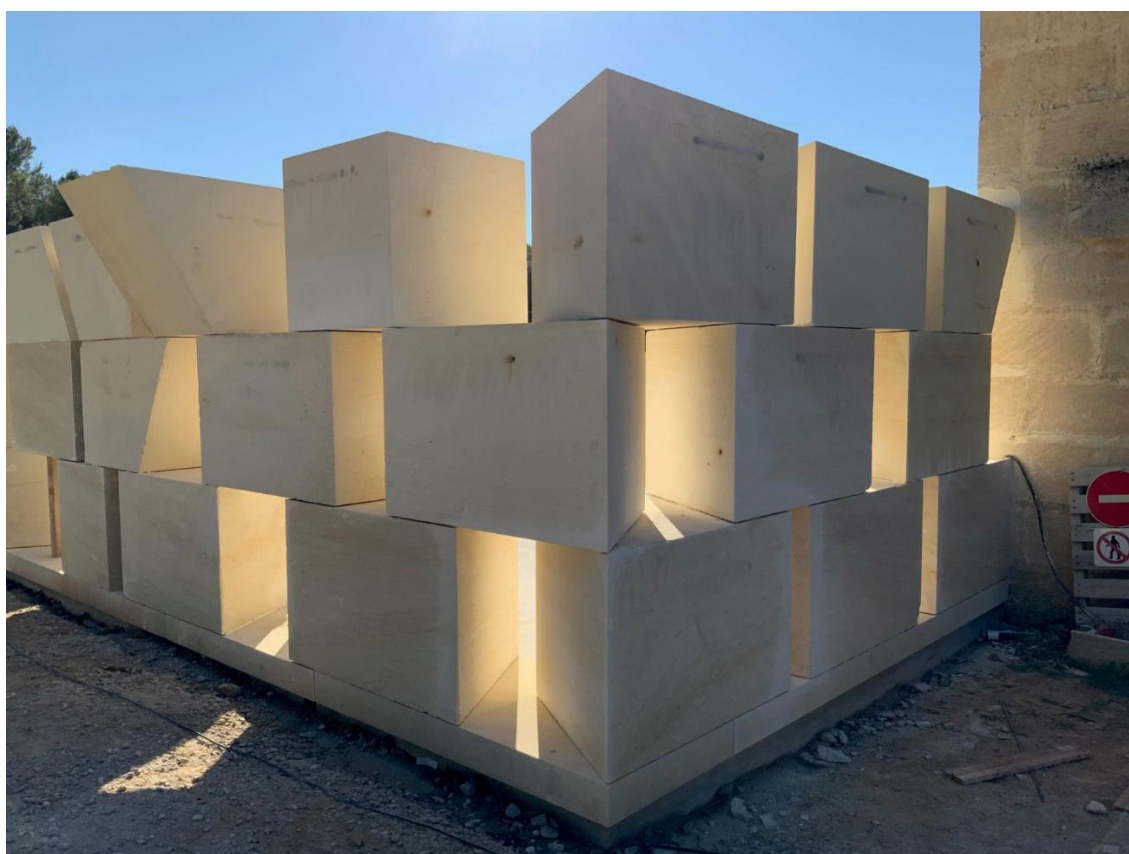
Figura 74| Edificação das paredes sem recurso a argamassa sobre a base de betão armado
