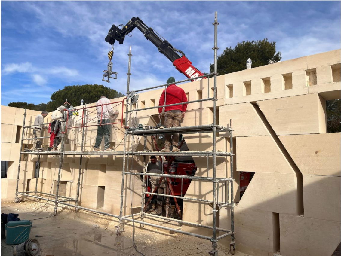
Figura 75| Encaixes esculpidos nos blocos (Atelier Architecture Perraudin)
