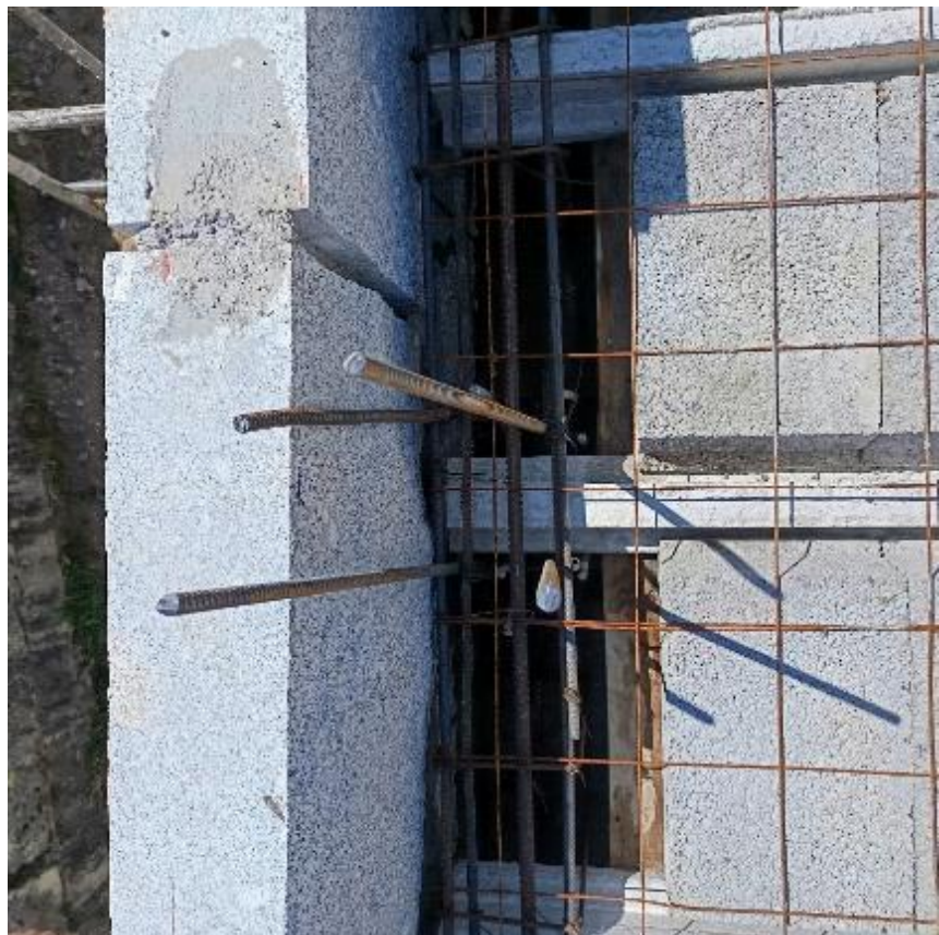
Figura 103| Viga de betão armado ao lado de parede de pedra (Autora,2024)
