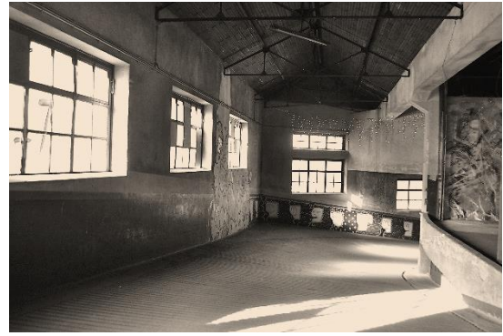
Fig. 79 Rampa de acesso, vista do piso superior
