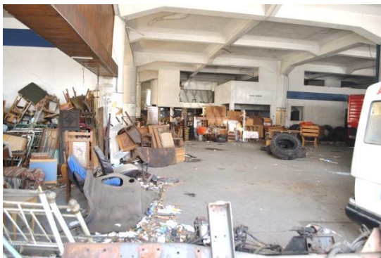
Fig. 24 Lixo que existia no piso 0
