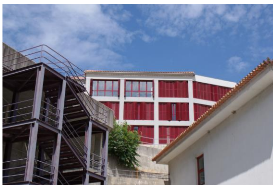
Fig. 78 Parte traseira do Pólo de Engenharia
