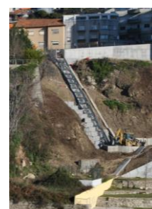
Fig. 59 Elevador da Goldra (construção)
