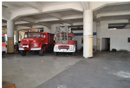
Fig. 23 Viaturas dos bombeiros, que se encontravam no espaço
