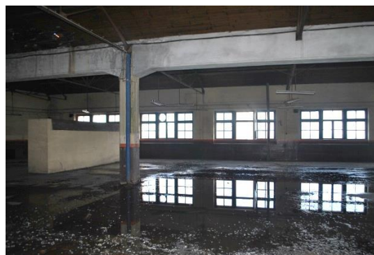
Fig. 34 Piso 2, vista sob a fachada principal
