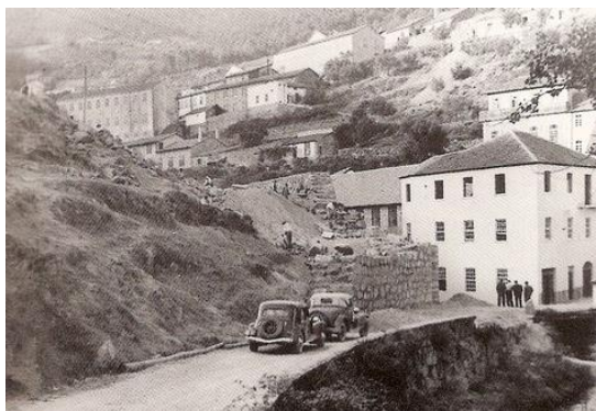
Fig. 41 Construção do muro de suporte para a Fábrica de Ernesto Cruz & C. a , década de 30
