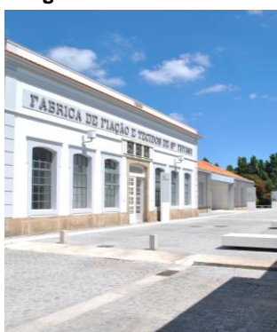
Fig. 73 Fachada do centro interpretativo
