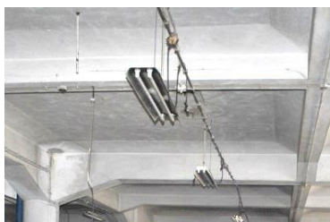
Fig. 43 Instalação elétrica existente
