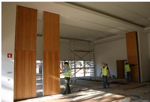
Fig. 82 Colocação de divisórias acústicas nusing premium
