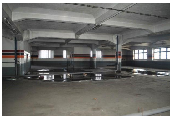
Fig. 31 Piso 1, fachada virada a este
