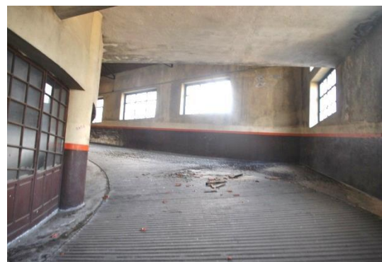
Fig. 32 Início da rampa que dá acesso ao piso 2
