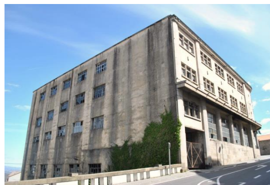
Fig. 14 Fachadas a oeste
