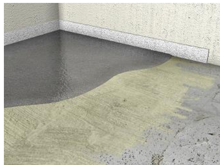
Fig. 83 Aplicação de autonivelante cimentício
