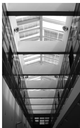
Fig. 81 Pormenor da cobertura
