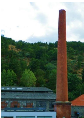
Fig. 18 Chaminé do Conjunto industrial da Fonte do Lameiro
