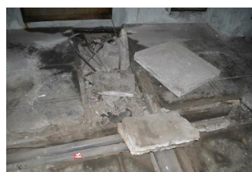
Fig. 108 Aberturas no chão para a instalação de canos
