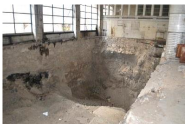
Fig. 46 Fosso no piso 0
