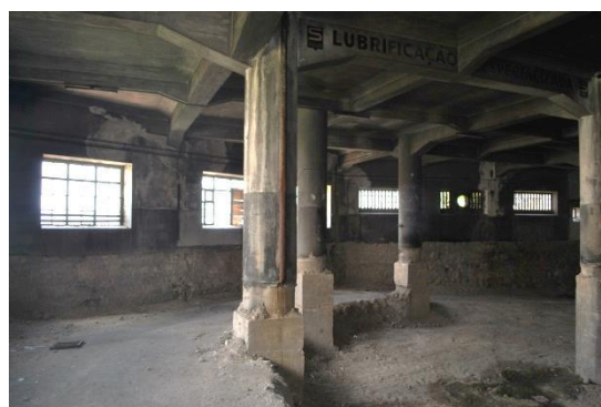
Fig. 19 Final da rampa, fachada este do piso -1
