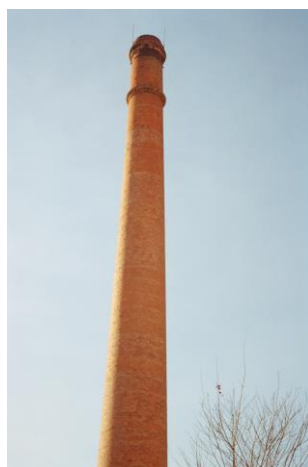
Fig. 19 Chaminé da Fábrica Têxtil Sampaio Ferreira & C a Lda
