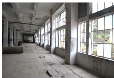
Fig. 104 Vãos das janelas
