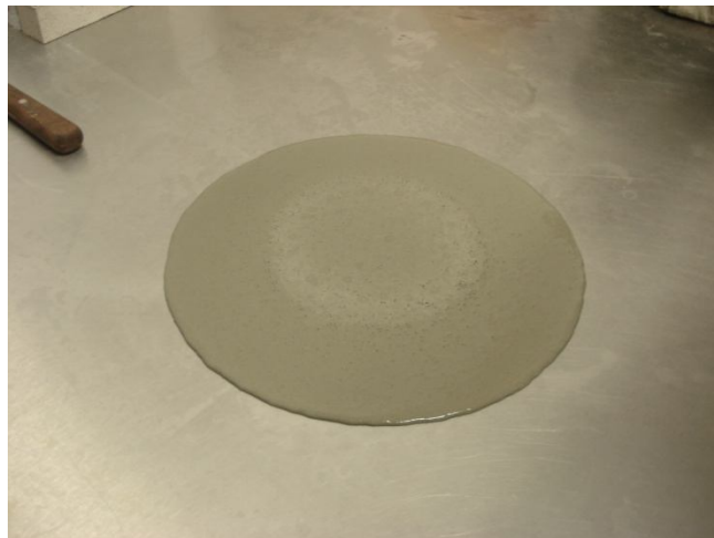
Figura 3.12 - Argamassa espalhada sobre a superfície
