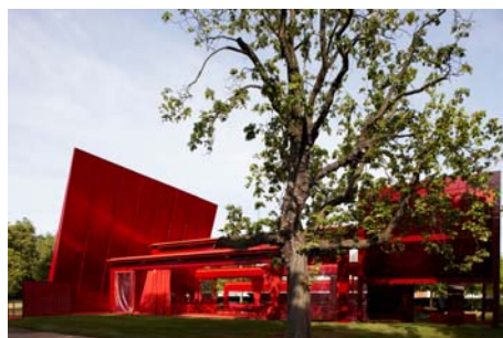
Fig. 2.72 - Vista exterior, pavilhão de Jean Nouvel, 2010.
