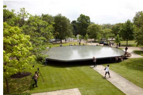
Fig. 2.85 - Vista da cobertura, pavilhão de Jaques Herzog e Pierre de Meuron com Ai Weiwei, 2012.
