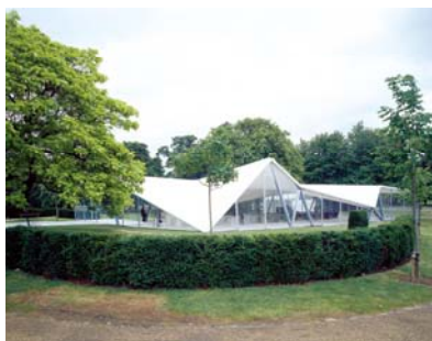
Fig. 2.1 - Vista exterior Sul, pavilhão de Zaha Hadid, 2000.
