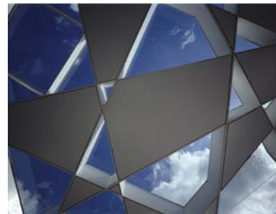
Fig. 2.20 - Vista das aberturas da cobertura, pavilhão de Toyo Ito, 2002.
