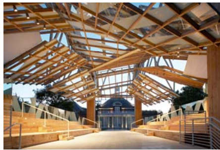
Fig. 2.60 - Vista interior para o edifício da Serpentine Gallery , pavilhão de Frank O. Gehry, 2008.
