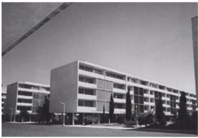
Fig. 16- Edifício elevado sobre pilotis, Bairro das estacas
