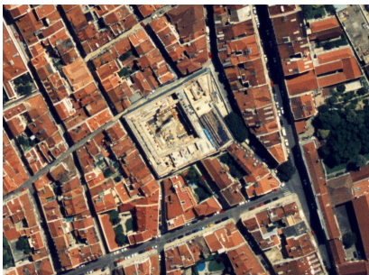
Fig.57-Convento das Bernardas de Lisboa durante as obras de reabilitação
