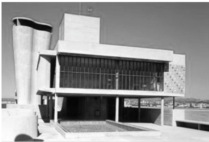
Fig.19- Terraço da Unidade habitacional
