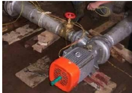
Figura 1.2.2.: Vista parcial da PAT de Thima (Quênia) com uma potência instalada de 2,2 kW - Williams e Rodrigues (2008).
