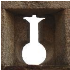
Figura 11 - Seteira de fortificação (Fonte: SiteCMSabugal, 2015)
