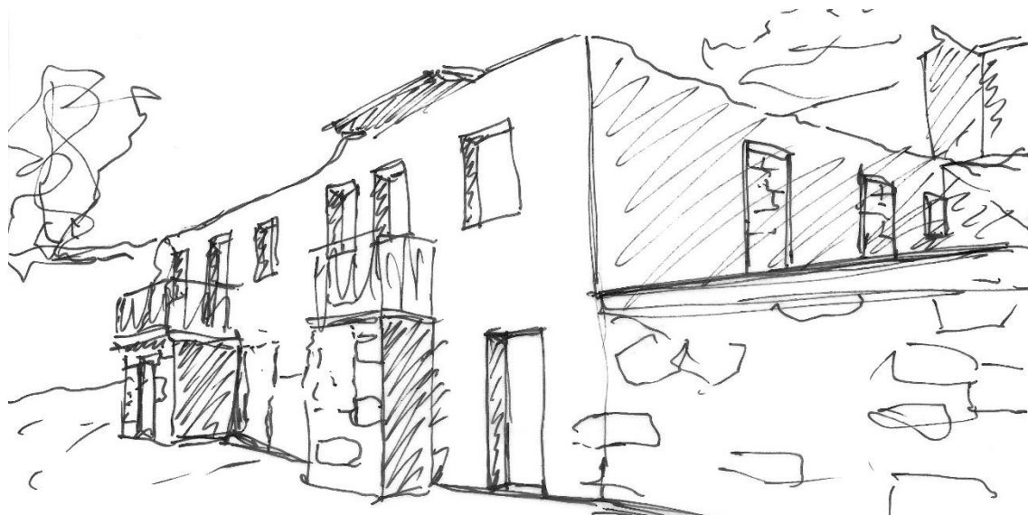
Figura 51: Vista Inferior de Nascente para Poente (Piso Inferior e Intermédio em Primeiro Plano)
