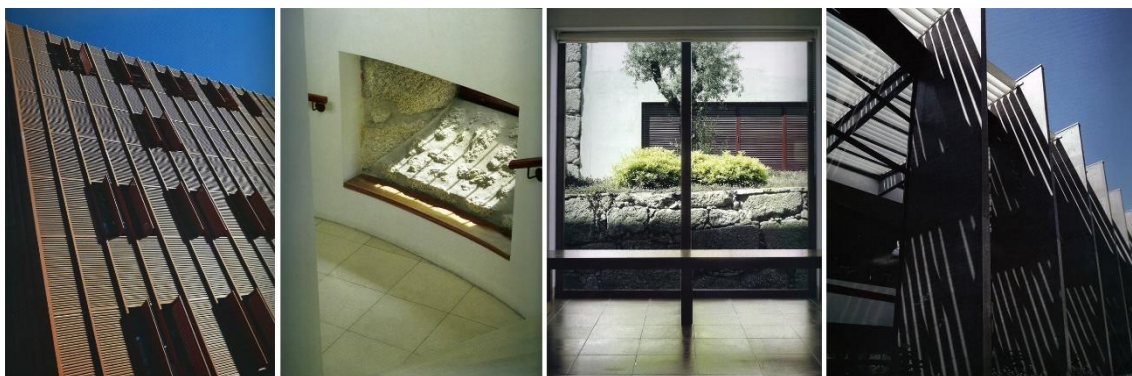
Figura 46: Fachada sul do Pólo Principal; Escada Circular Pólo Principal; Vista para a passagem exterior norte da Biblioteca; Fachada posterior norte da Biblioteca
