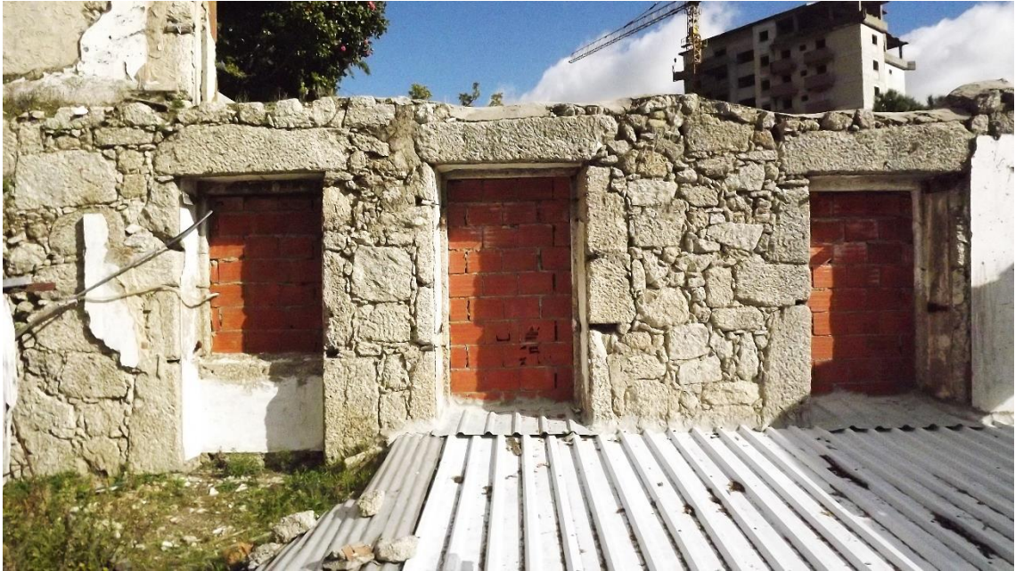
Figura 14: Vista interior dos vão virados a Noroeste
