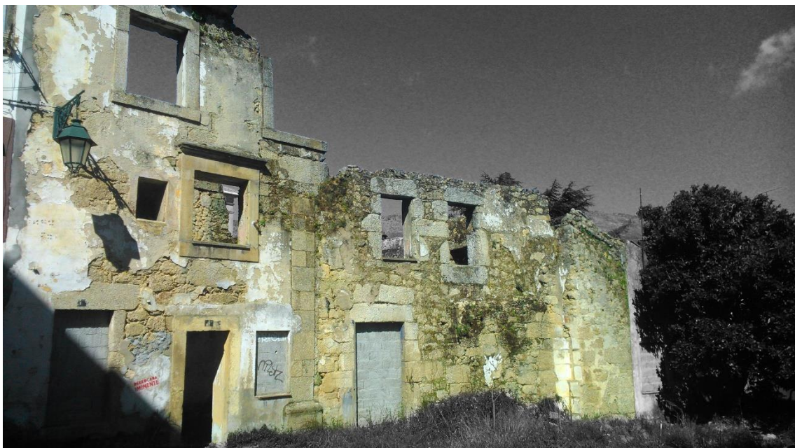
Figura 20: Rua do Castelo
