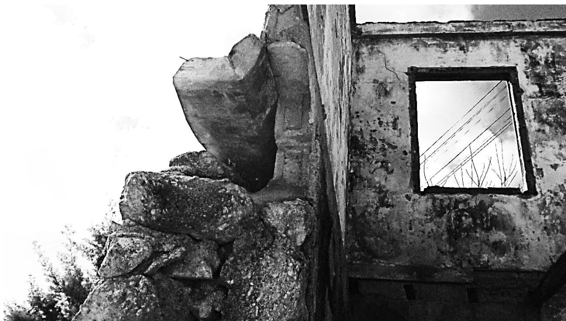
Figura 55: Pormenor da união entre Alvenaria de Pedra e Alvenaria de Betão
