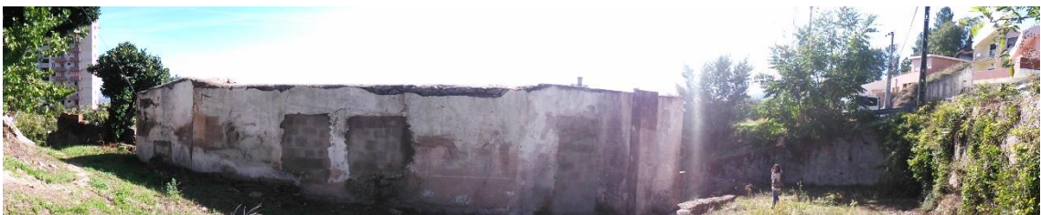
Figura 6: Panorâmica da fachada Noroeste
