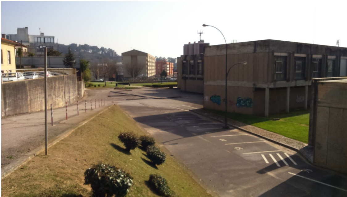
Figura 32 – Fotografia do edifício devoluto – fachada nordeste, com parque de estacionamento.
