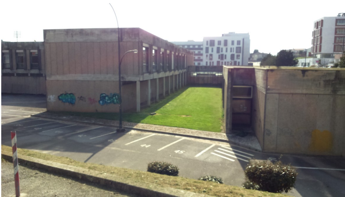
Figura 31 — Fotografia do edifício devoluto — fachada nordeste.
