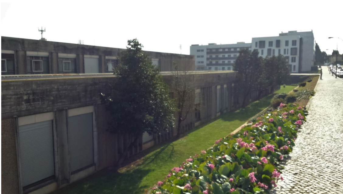
Figura 30 — Fotografia do edifício devoluto — fachada noroeste, com jardim.
