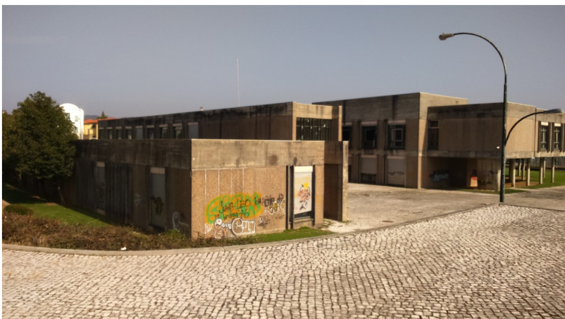
Figura 29 – Fotografia do edifício devoluto – fachadas sudoeste e noroeste.
