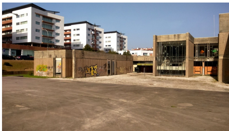
3.1. Figuras 13 e 14 – Fotografias do edifício devoluto – fachada sudoeste.
