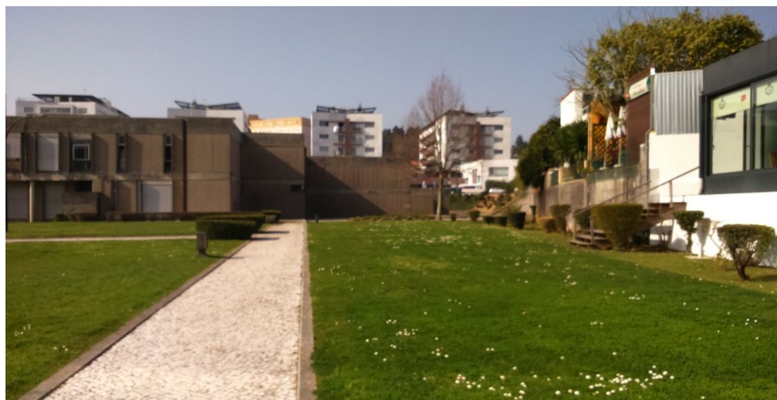
Figura 25 – Fotografia do edifício devoluto – jardim.
