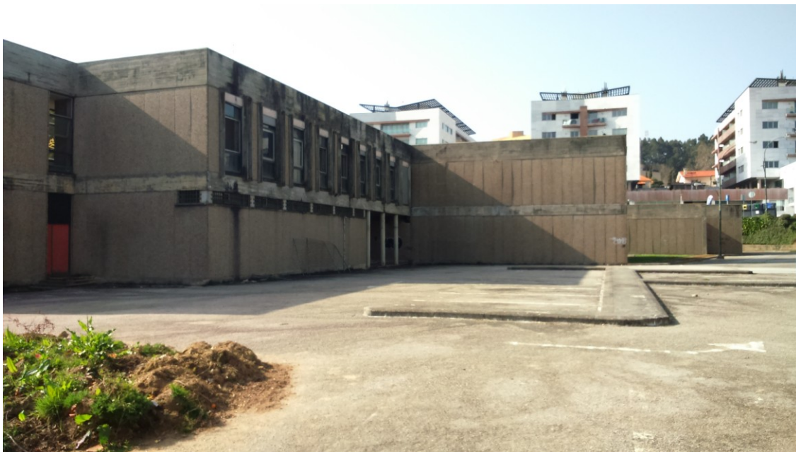
Figura 33 – Fotografia do edifício devoluto – fachada nordeste, com parque de estacionamento.
