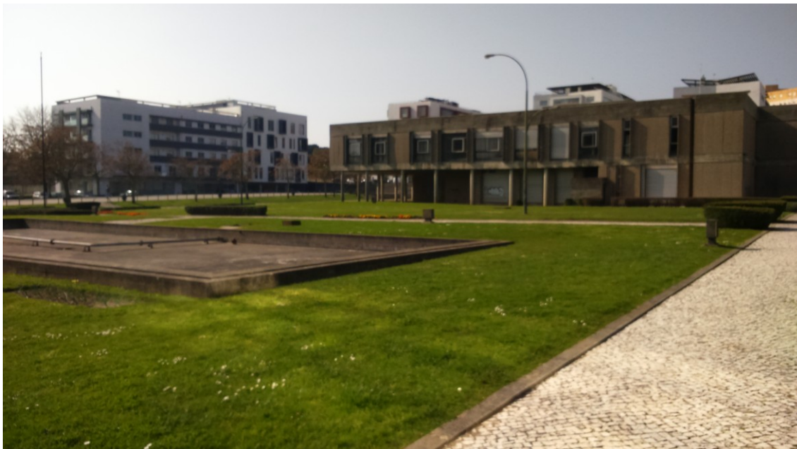
Figura 26 – Fotografia do edifício devoluto – jardim com lago.
