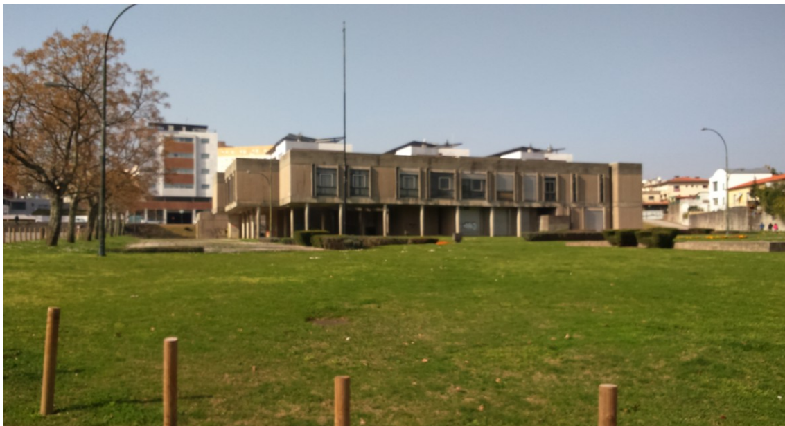
Figura 24 – Fotografia do edifício devoluto – fachada sudeste.
