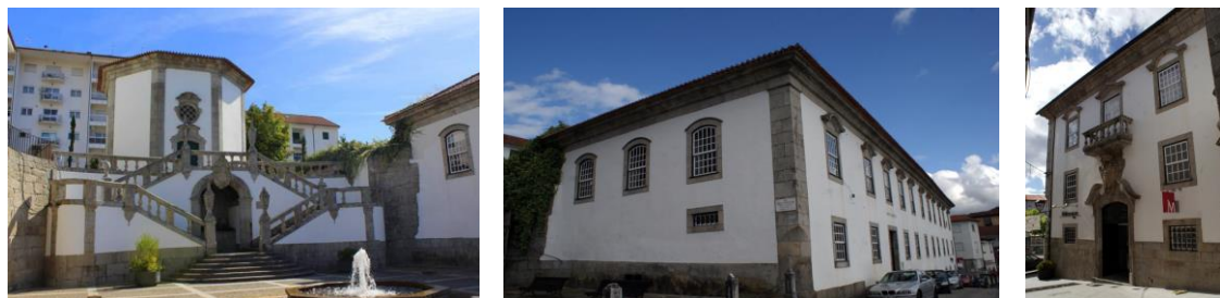
Figura 28 – Capela das Carrancas (esquerda) e Casa da Cerca (imagem do centro e imagem da direita) (“Net 17|,” 2018; “Net 18|,” 2012).
