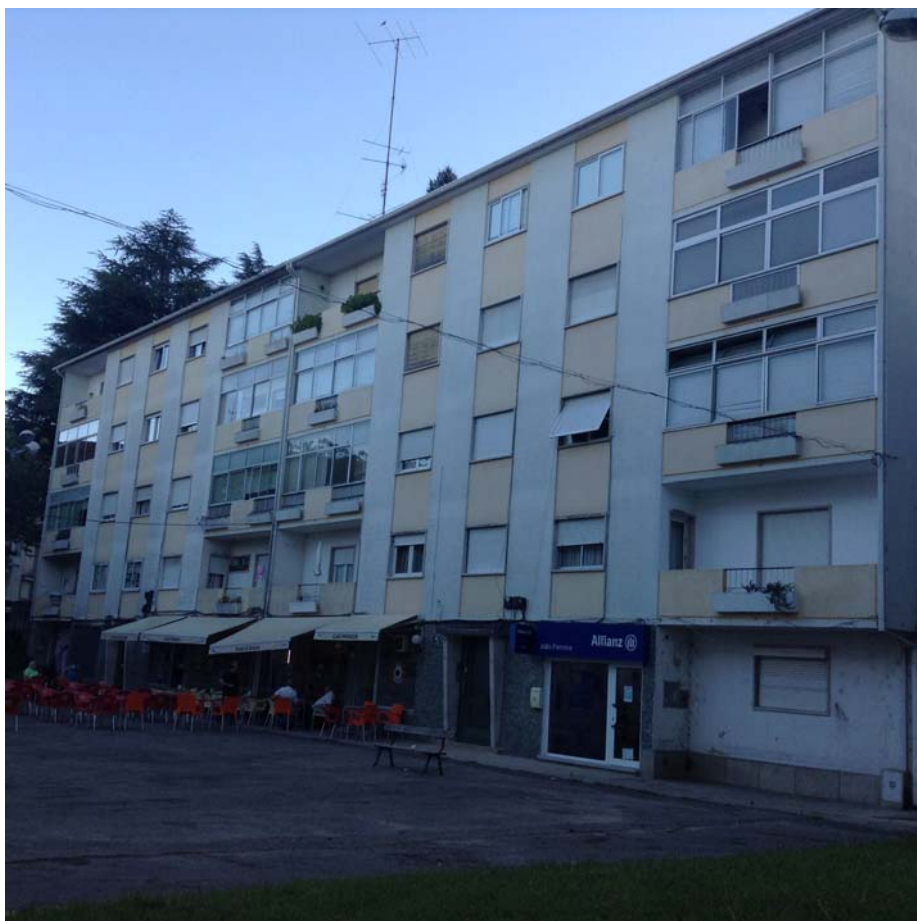
Figura 3.16 Fachada principal do edifício
