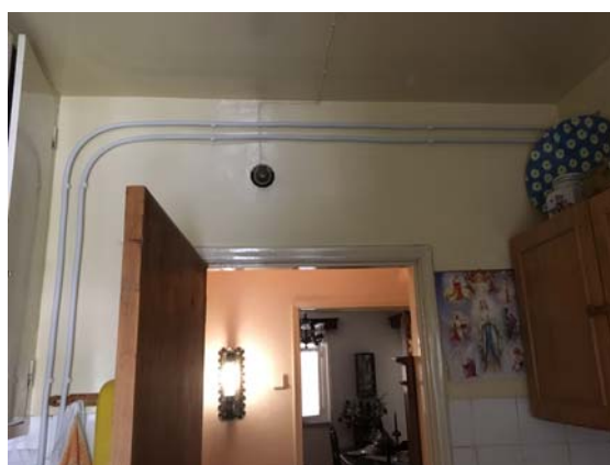
Tubagem à vista
