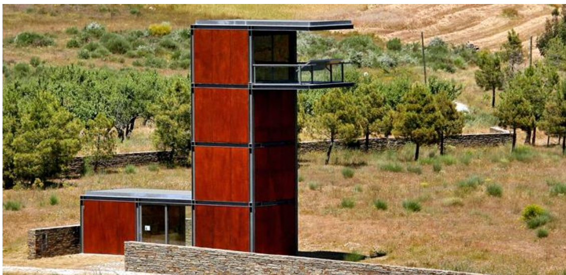
Figura 32 - Elemento vertical com vista para o Castelo Velho
