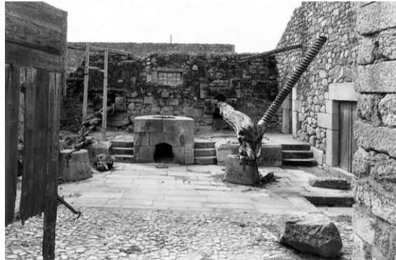
Fig. 41 Estado antes da intervenção
