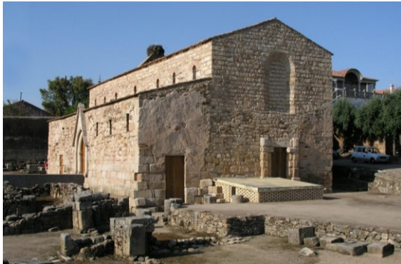
Fig. 30 Estado antes da intervenção
