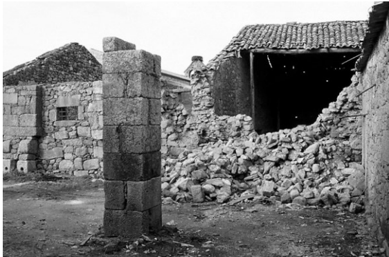
Fig. 40 Estado antes da intervenção
