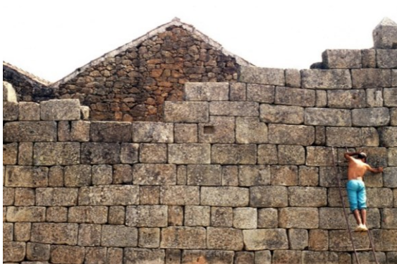
Fig. 22 Processo de Obra
