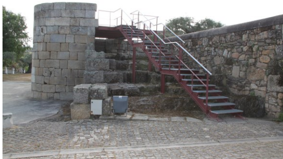
Fig. 80 Acesso percurso sobre a muralha
