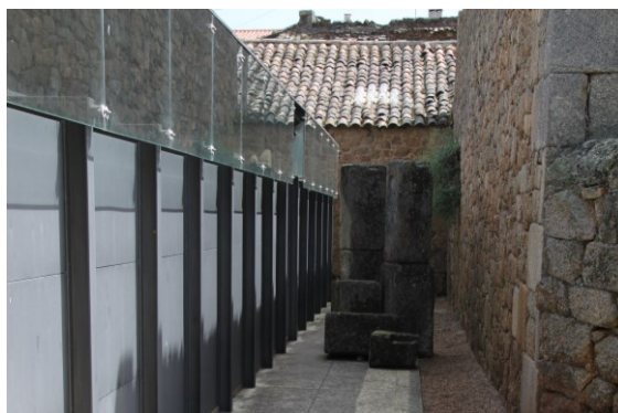
Fig. 55 Vista Sul depois da intervenção
