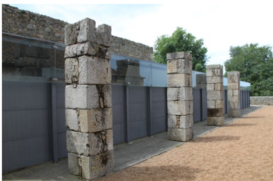
Fig. 54 Vista Norte depois da intervenção
