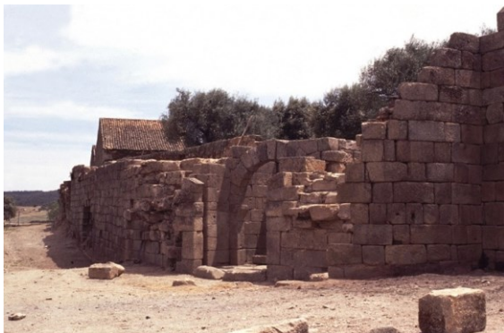
Fig. 20 Estado antes da intervenção
