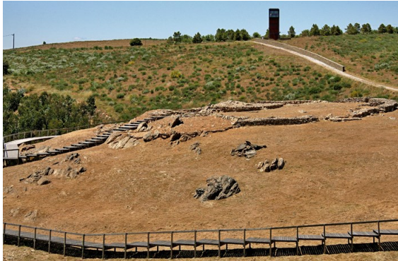
Fig. 74 Vista Sudeste depois da intervenção
