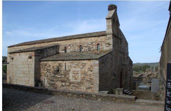
Fig. 35 Vista Nordeste depois da intervenção
