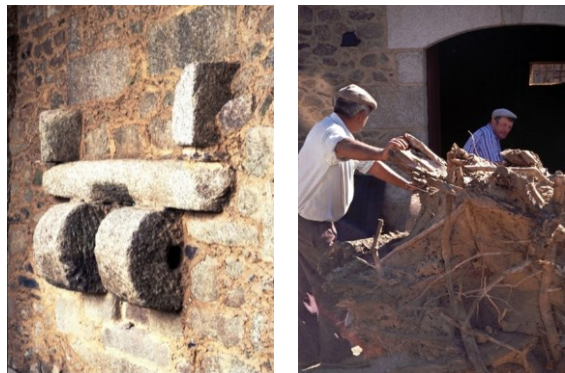
Fig. 43 Processo de Obra - Colocação das Varas
