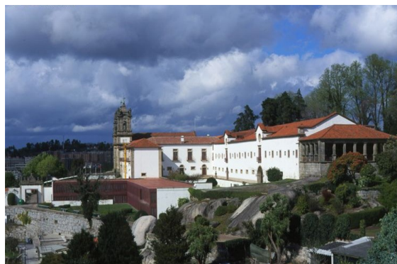
Fig. 15 Sta. Marinha da Costa- após a intervenção
