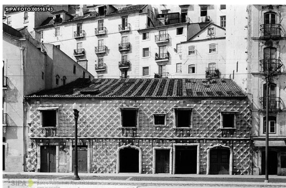
Fig. 12 Casa dos Bicos- antes da intervenção
