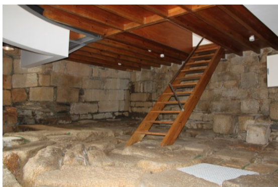
Fig. 65 Interior depois da intervenção
