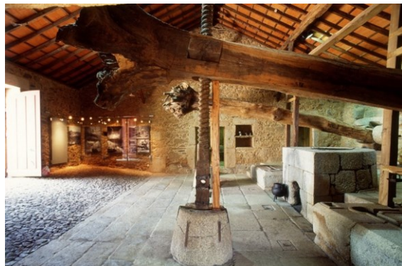
Fig. 45 Interior depois da intervenção
