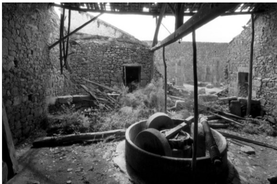
Fig. 42 Estado antes da intervenção
