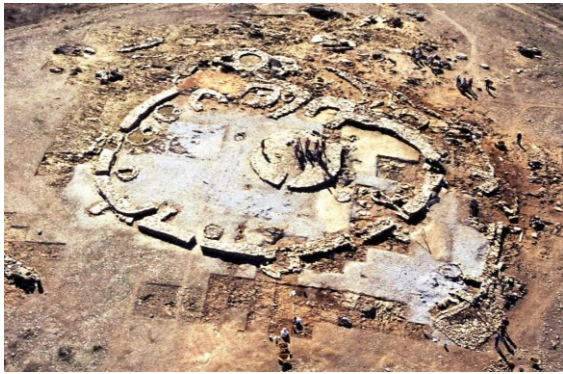
Fig. 72 Estado antes da intervenção
