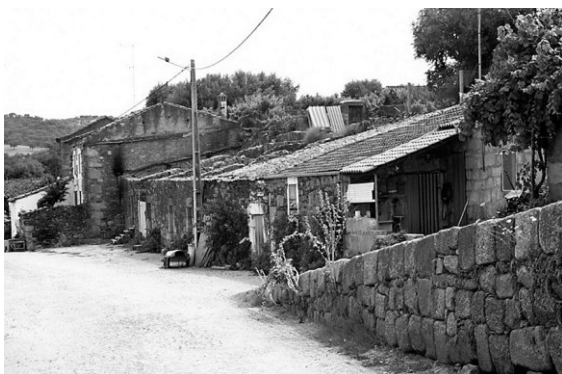
Fig. 60 Estado antes da intervenção
