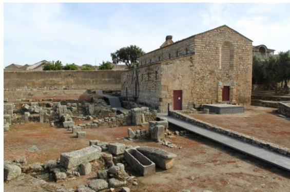
Fig. 33 Vista Sul depois da intervenção
