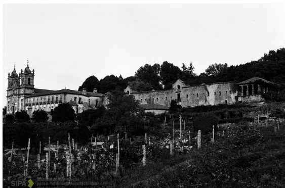
Fig. 14 Sta. Marinha da Costa- antes da intervenção
