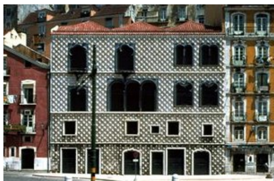
Fig. 13 Casa dos Bicos- após a intervenção
