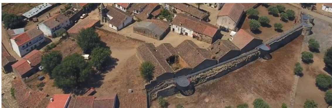
Fig. 18 Vista aérea da Intervenção na Porta Norte e Muralha Romana
