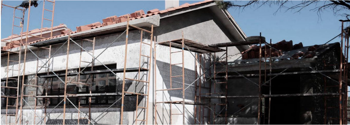
Figura 57| Substituição da telha original por telha lusa similar à existente
