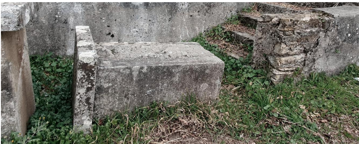
Figura 35| Estado atual do acesso ao interior do lote (janeiro 2025)
