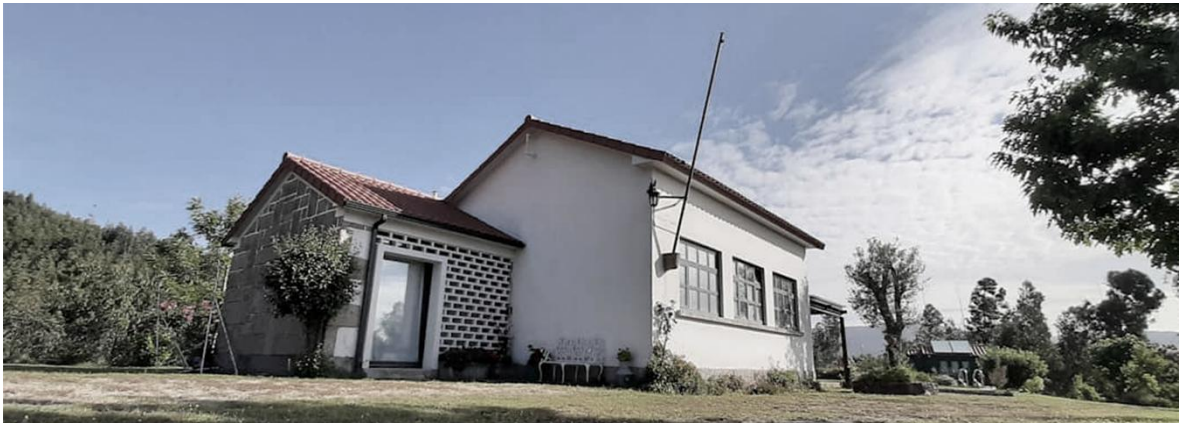
Figura 72| Resultado após concretização do projeto idealizado pelo Arq. André Rocha
