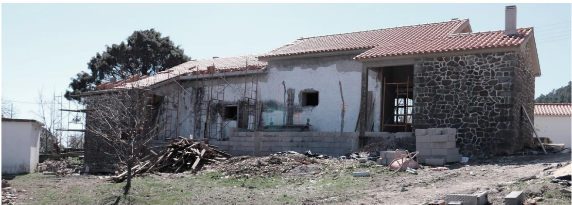
Figura 58| Alçado tardoz, em fase de obra
