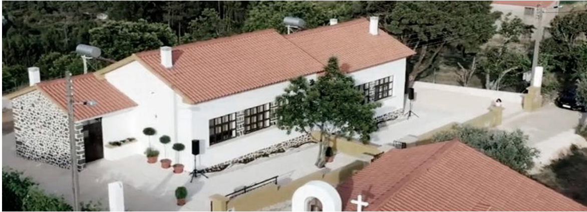
Figura 59| Resultado após a intervenção do Município de Proença-a-Nova
