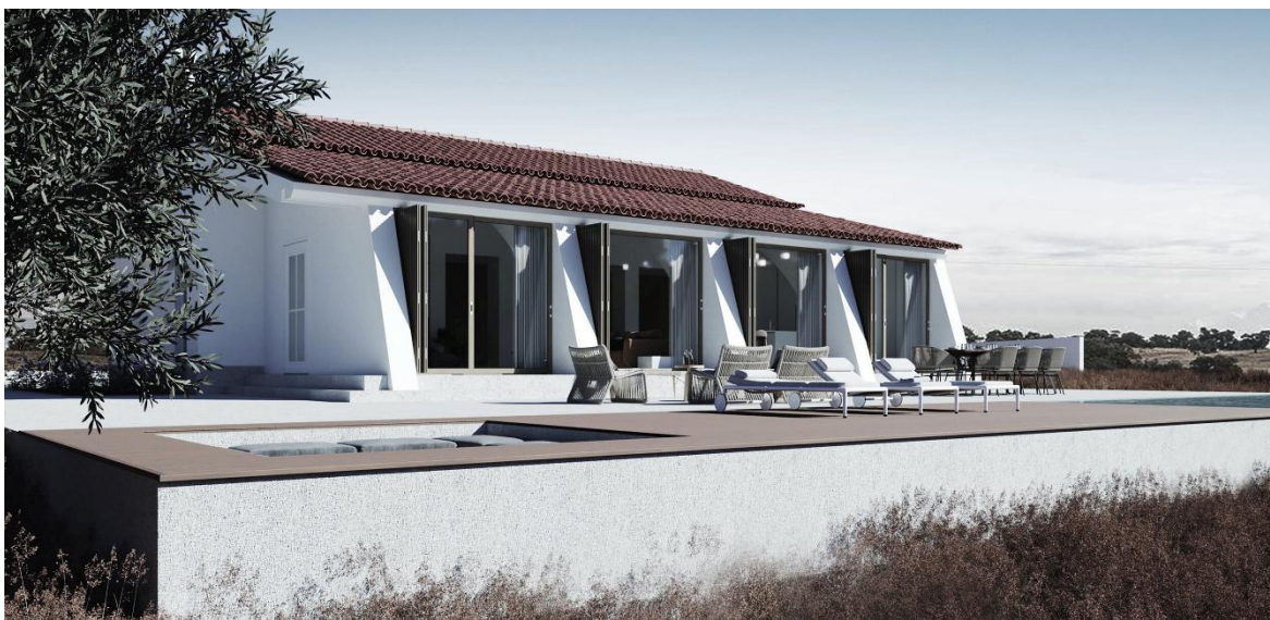
Figura 81| Edifício após intervenção
