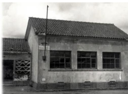
Figura 60| Edifício original do ano de 1964, Garafim
