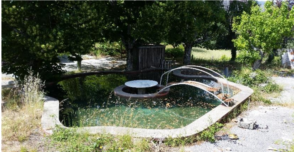
Fig. 24 - Estado atual da habitação - Piscina
