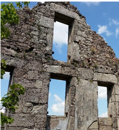
Fig. 20 - Estado atual da habitação - Alçada Nordeste
