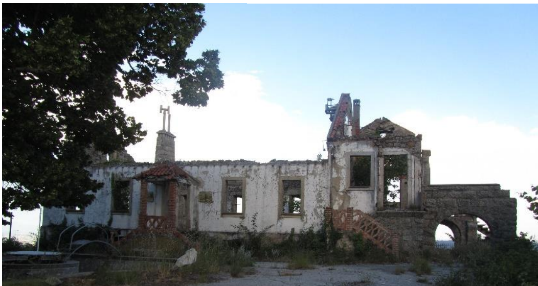
Fig. 23 - Estado atual da habitação - Alçada Noroeste
