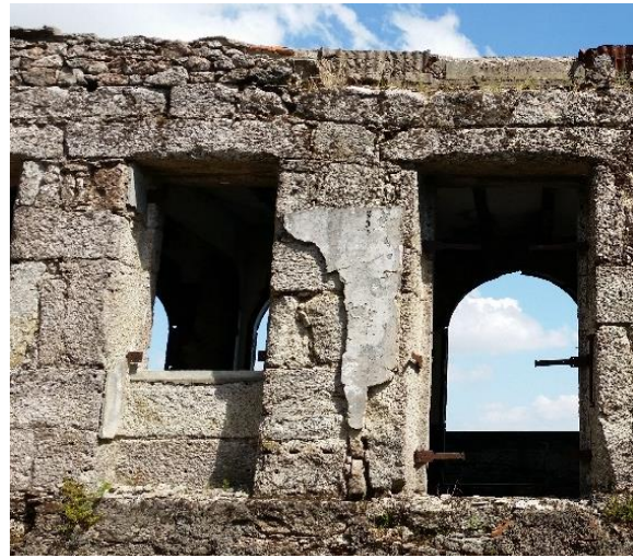
Fig. 22 - Estado atual da habitação - Antigo Alçada Sudeste (antes do acrescento de 1954)
