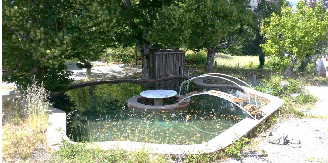
Fig. 33 - Piscina junto ao Alçado Noroeste
