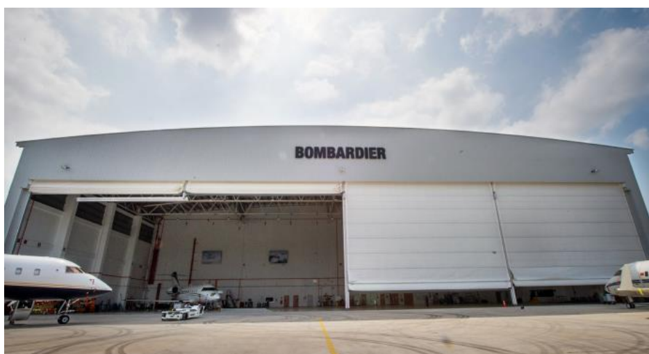
Figura 10.1 Megadoor VL 3190 em Hangar da Bombardier
