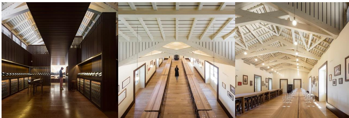
Figura 12 - Fotografias do interior do edifício
