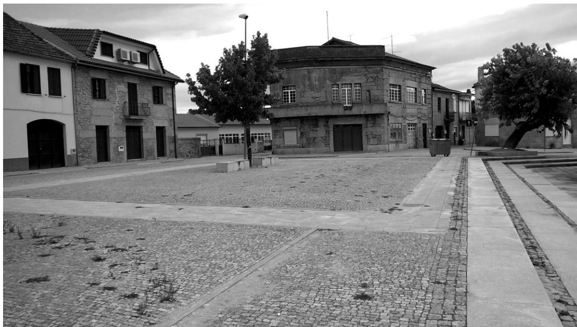
51 - Perspetiva da zona em análise - Zona E, 2015
