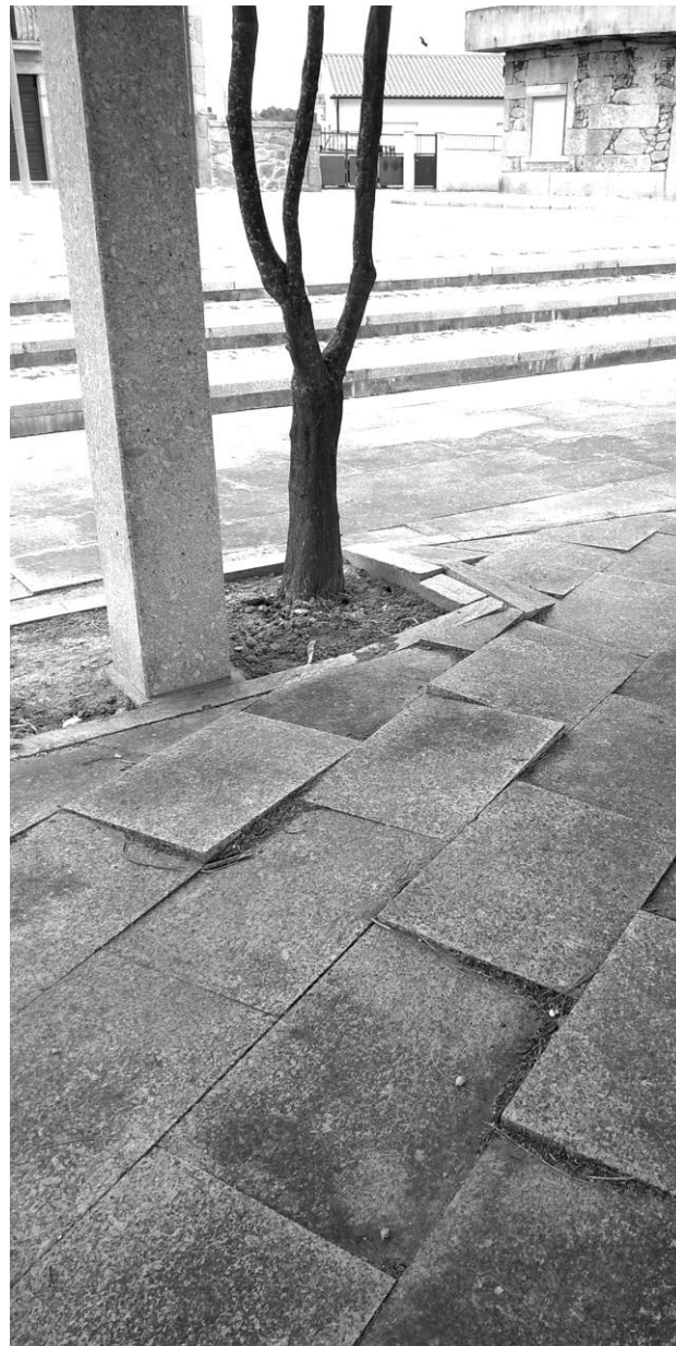
56 - Pormenor da pavimentação na zona sob a pérgula, 2015
