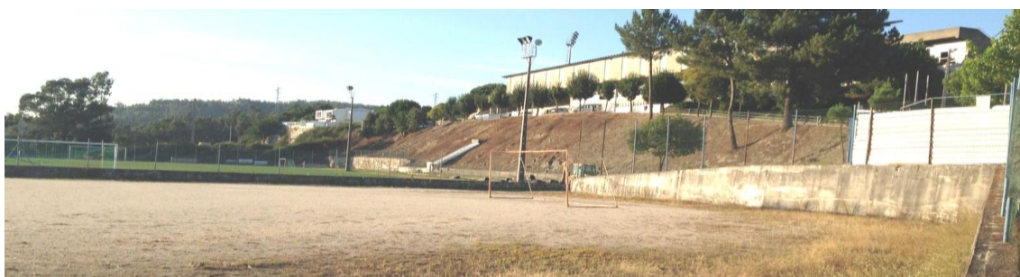
Figura 13 - Fotografia geral do complexo desportivo.
