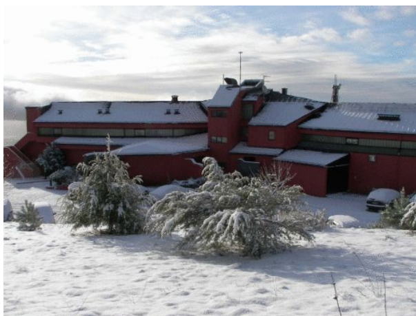
Figura 11 - Estalagem Varanda Dos Carqueijais **** - Covilhã
