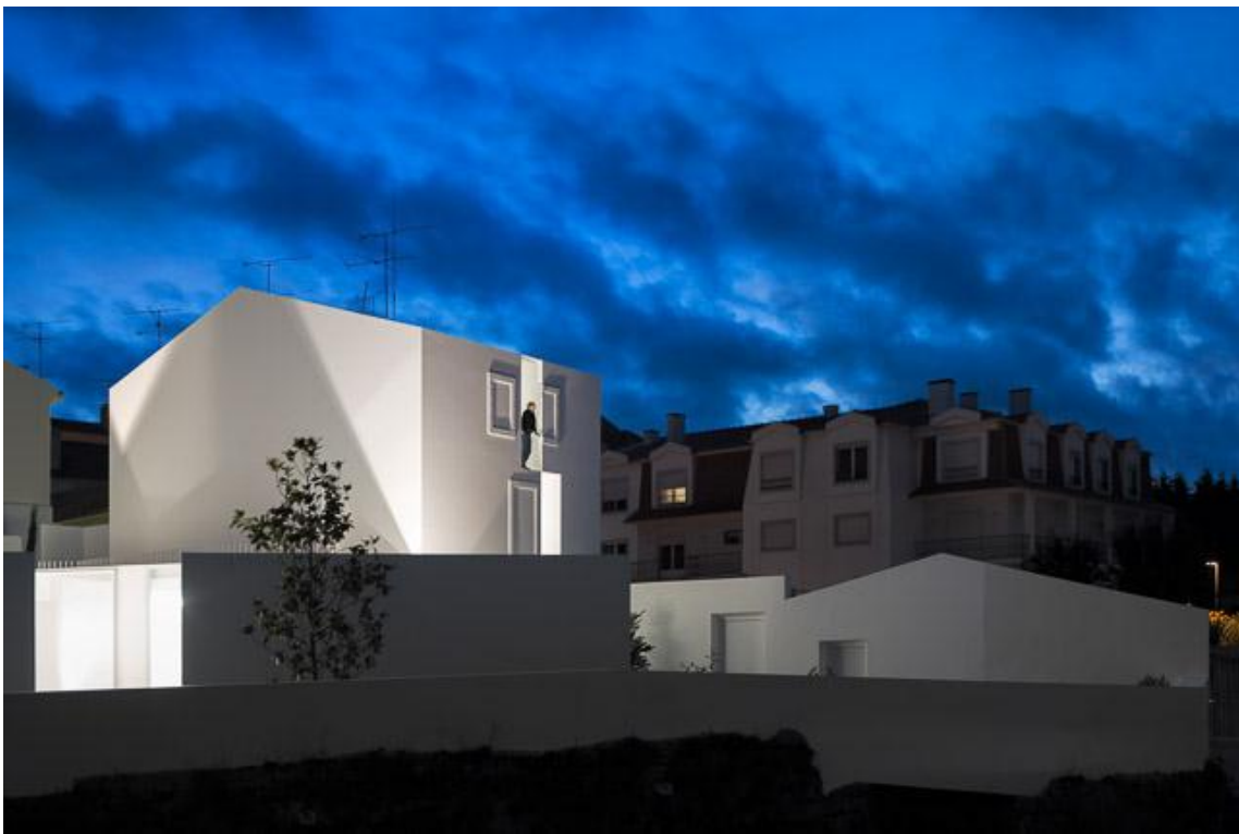
Figura 60 -Casa em Alcobaça. Alcobaça, Portugal. Arquitectos Aires Mateus. Fotografia de Fernando Guerra.
