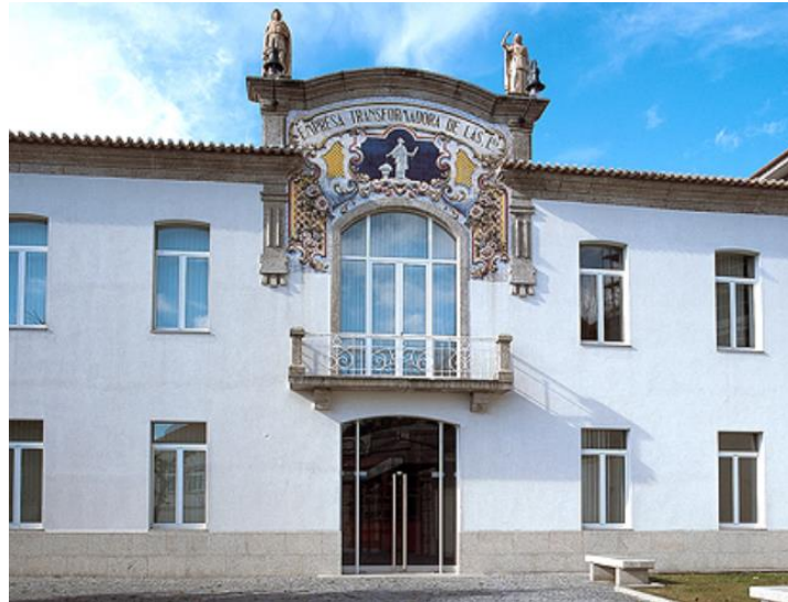
Figura 14 - Alçado Nascente da Transformadora de lãs, atual.
