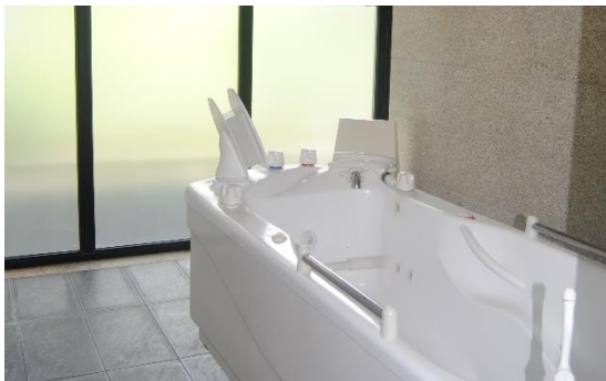
Figura 23 - Banheira de hidromassagem
