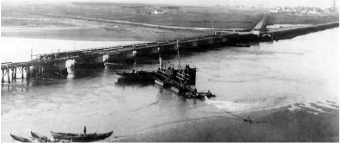
Figura 3 - «Ponte das duas Águas»
