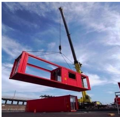
Figura 2.37: Manuseamento de contentor com grua móvel ([17] TempoHousing).
