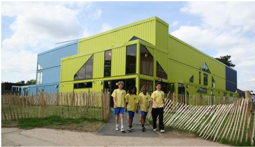
Figura 2.25: Pavilhão desportivo de escola em Londres ([24] Container City).
