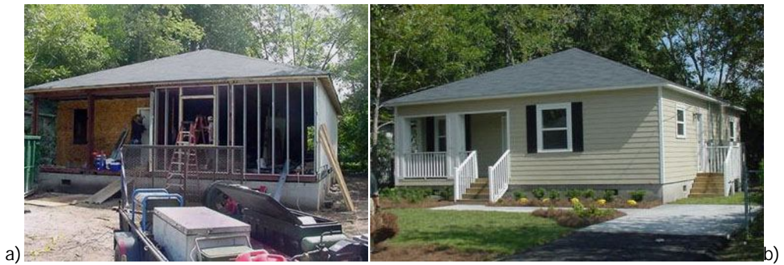
Figura 2.28: Moradia com acabamento tradicional. a) Fase de construção; b) Finalizada ([31] Funktion).
