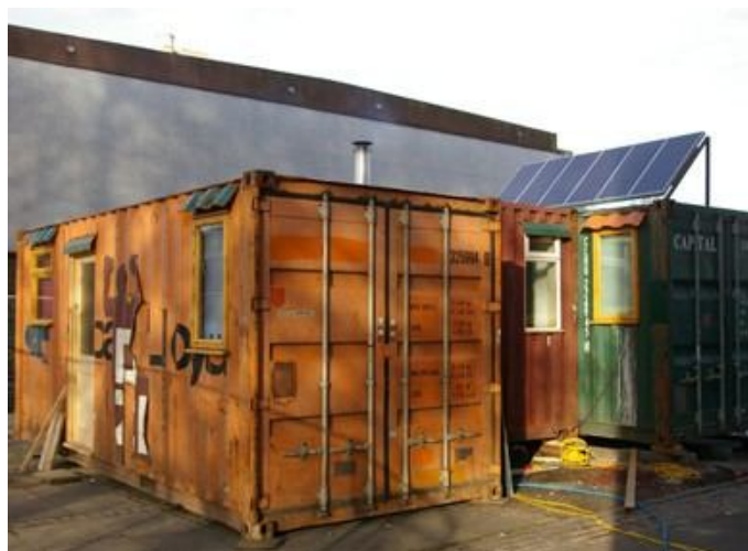
Figura 2.1: Contentores marítimos remodelados em estaleiro de obra (Portugal) ([18] National Geographic).
