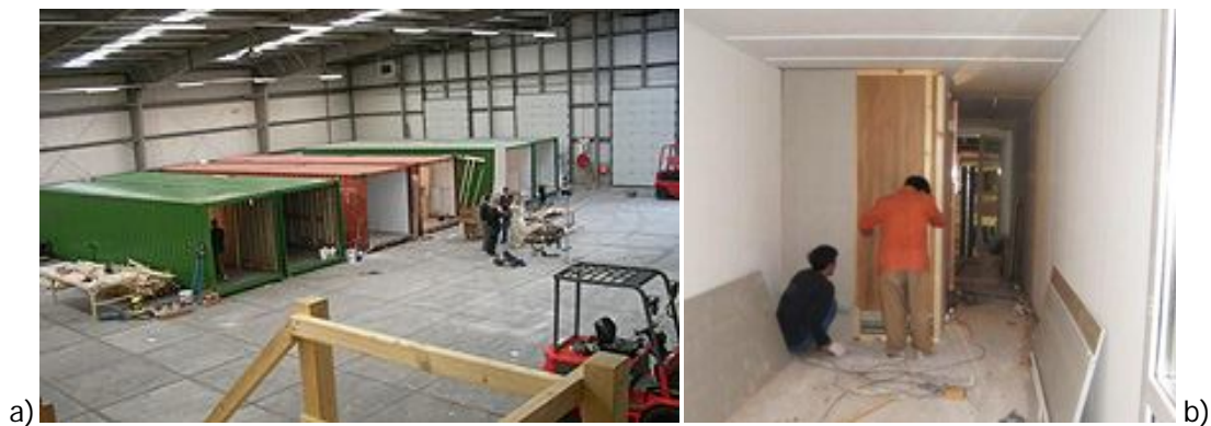
Figura 2.36: a) Oficina de remodelação; b) Execução de acabamentos ([17] TempoHousing).
