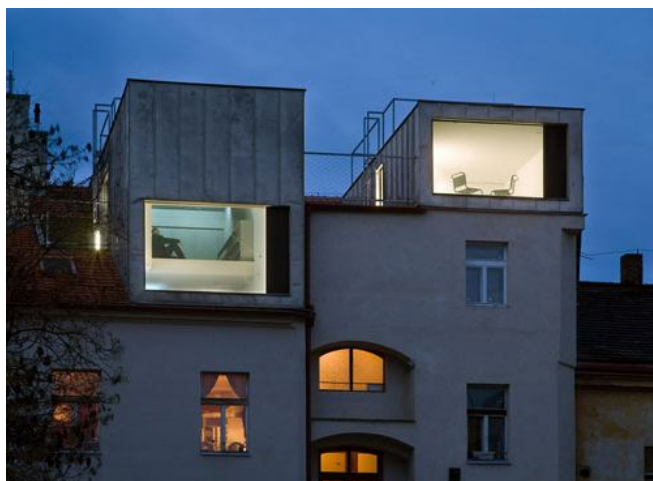
Figura 2.4: Ampliação de edifício. ([19] HSH)
