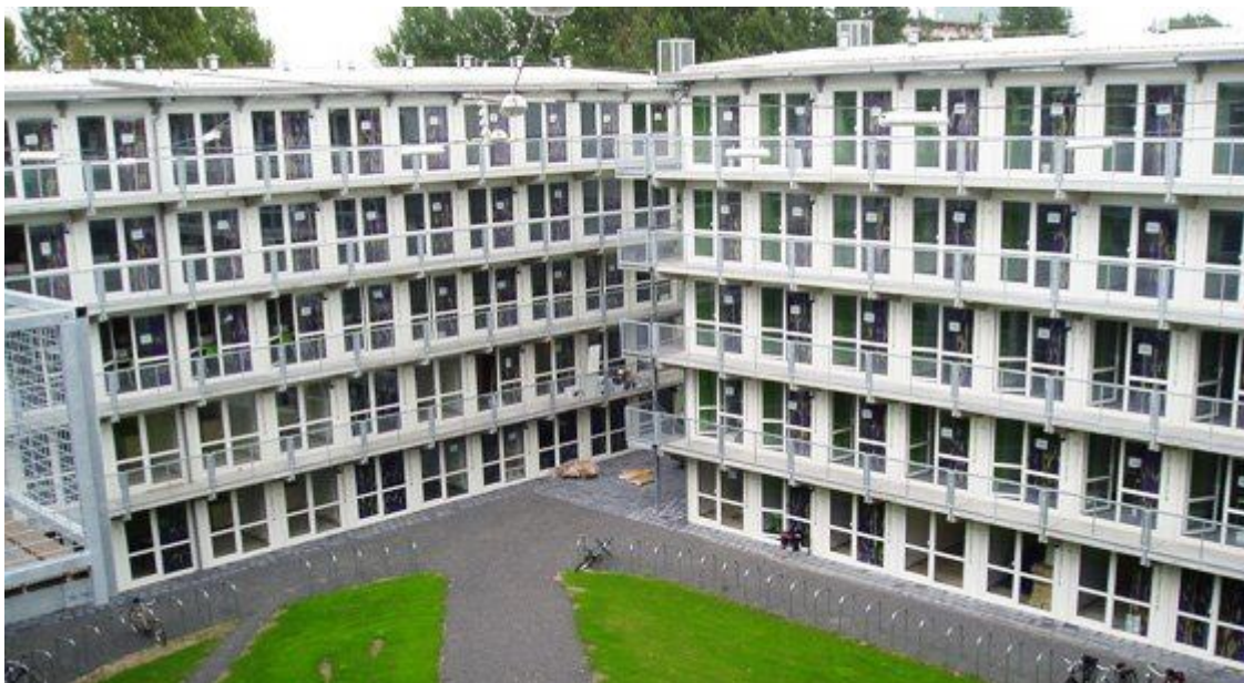
Figura 1.4: Complexo de residências universitárias, Holanda ([17] TempoHousing).
