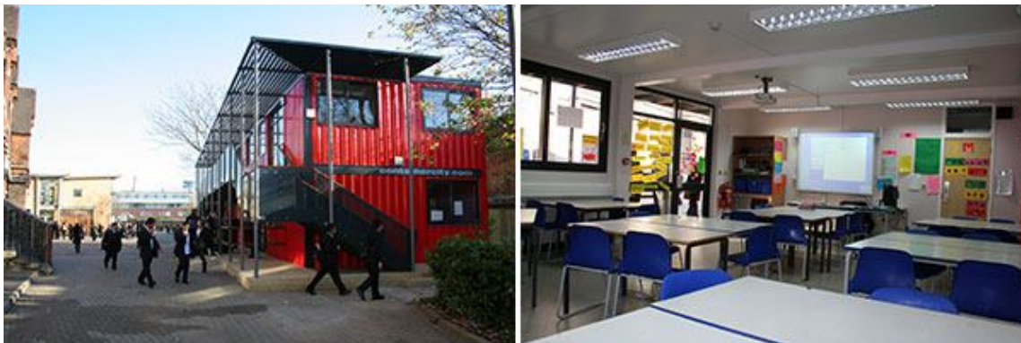
Figura 2.26: Escola em Portman Place - Londres ([24] Container City).
