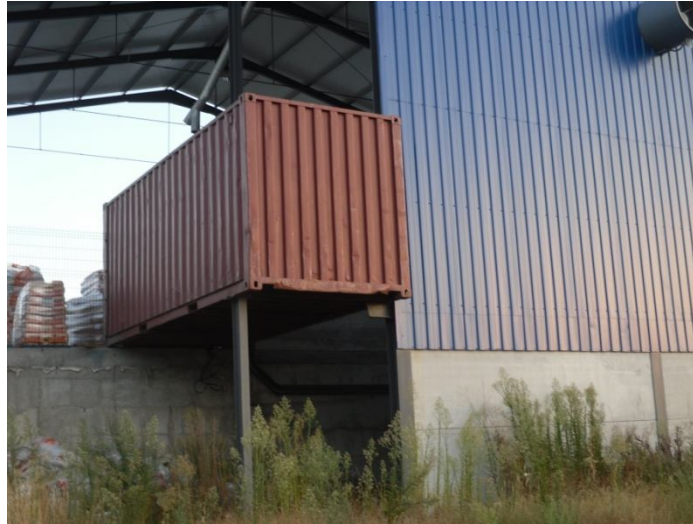
Figura 2.2: Reutilização de contentor marítimo (Portugal).
