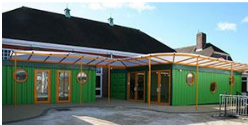
Figura 2.23: Escola em Londres ([24] Container City).
