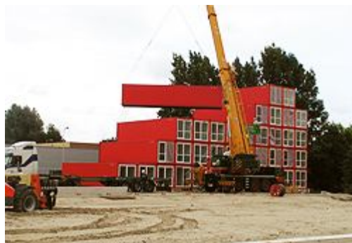
Figura 2.38: Fase de montagem de contentores ([17] TempoHousing).
