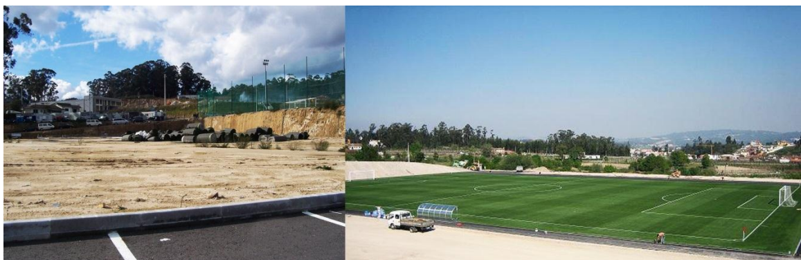
Fig.13- Estado actual da nova Cidade Desportiva de Paredes.
