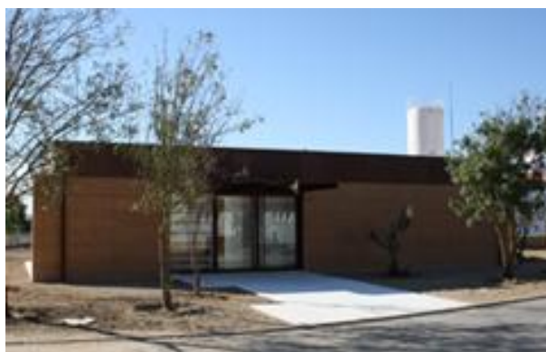
Figura 21 - Central de monitorização da estação de tratamento de águas residuais de Évora. Fonte: Águas do centro Alentejo (2011)
