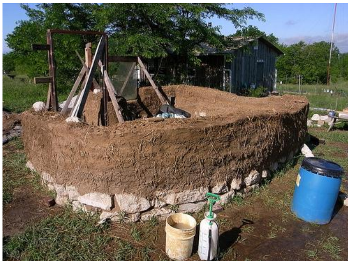
Figura 7 - Edifício em construção com o método terra empilhada.
