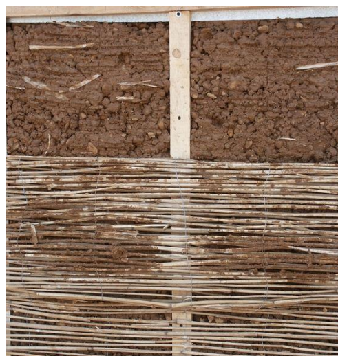
Figura 5 - Parede construída com o método terra plástica. Fonte: CRATerre [s.d.]
