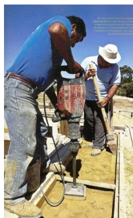
Figura 30 - Compactação da terra de forma mecanizada. Fonte: Caetano & Vasco (2011)
