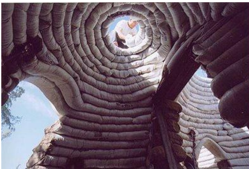
Figura 11 - Edifício em construção com o método da terra ensacada. Fonte: Capello (2010)
