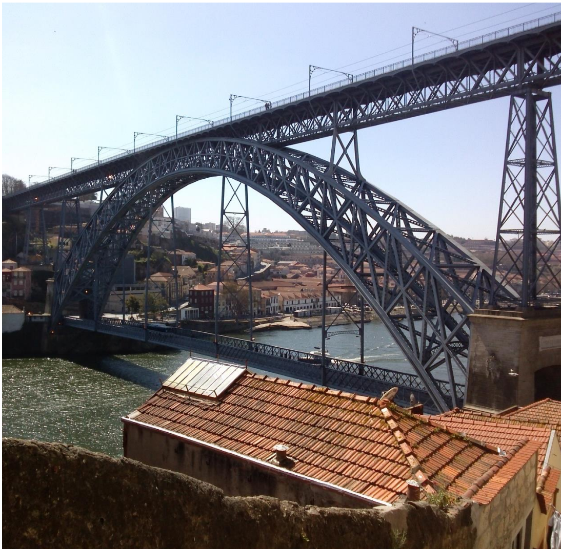
Figura 2 Ponte D. Luís I 2
