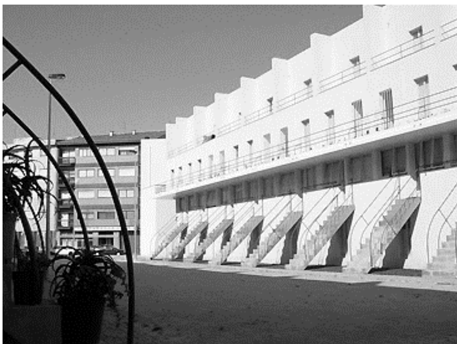
Figura 21 Bairro da Bouça, Porto - Construção SAAL 98
