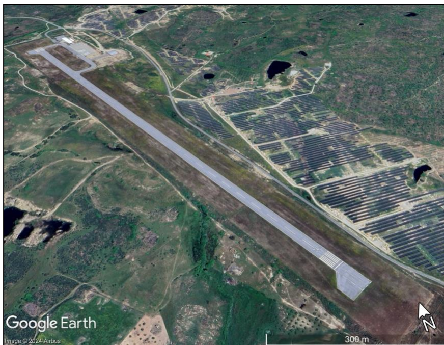
Figura 16 - Vista aérea do aeródromo de Castelo Branco – LPCB (adaptado de [88])
