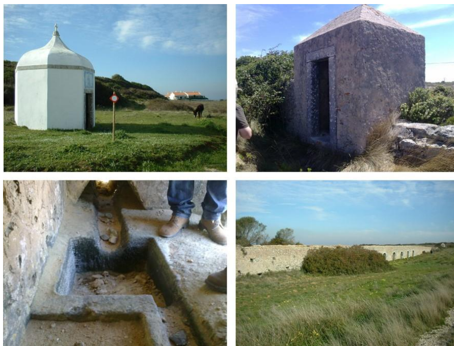
Figura 48. Imagens do Aqueduto do Cabo Espichel (Imagens fornecidas pelo Arquiteto da C.M.S. Armindo Pombo, em 2017)
