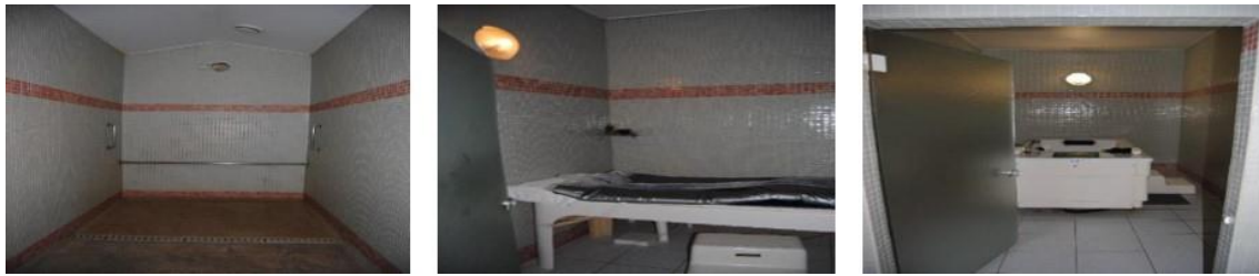
Figura 20. Zona de Jato de água, zona de termoterapia/algoterapia e zona de balneoterapia, no centro de talassoterapia da Costa da Caparica
