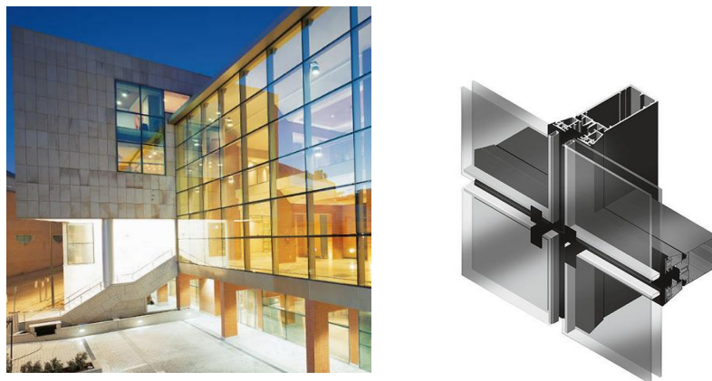
Figura 93. Fachada em cortina (Navarra, 2017)
