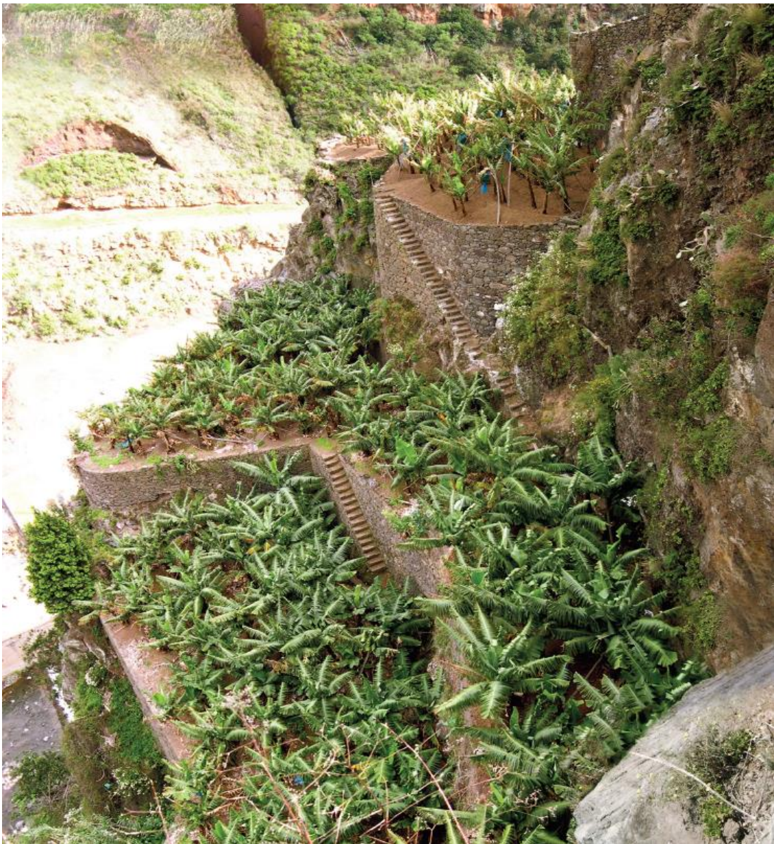
Figura 46: Escadas integradas nos poios Fonte: (Arquitetura de Pedra e na Pedra, Topografias Esculpidas, 2013)
