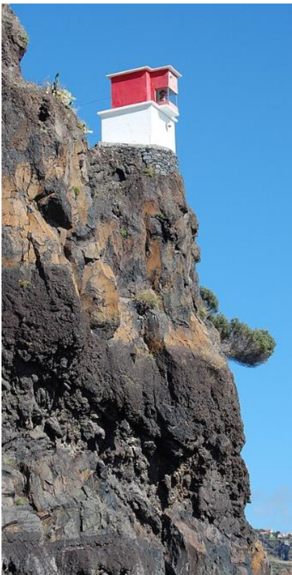
Figura 57: Perspetiva que desafia o imaginário da construção em escarpa na Ribeira Brava Fonte: (Farol da Ribeira Brava, 2009)
