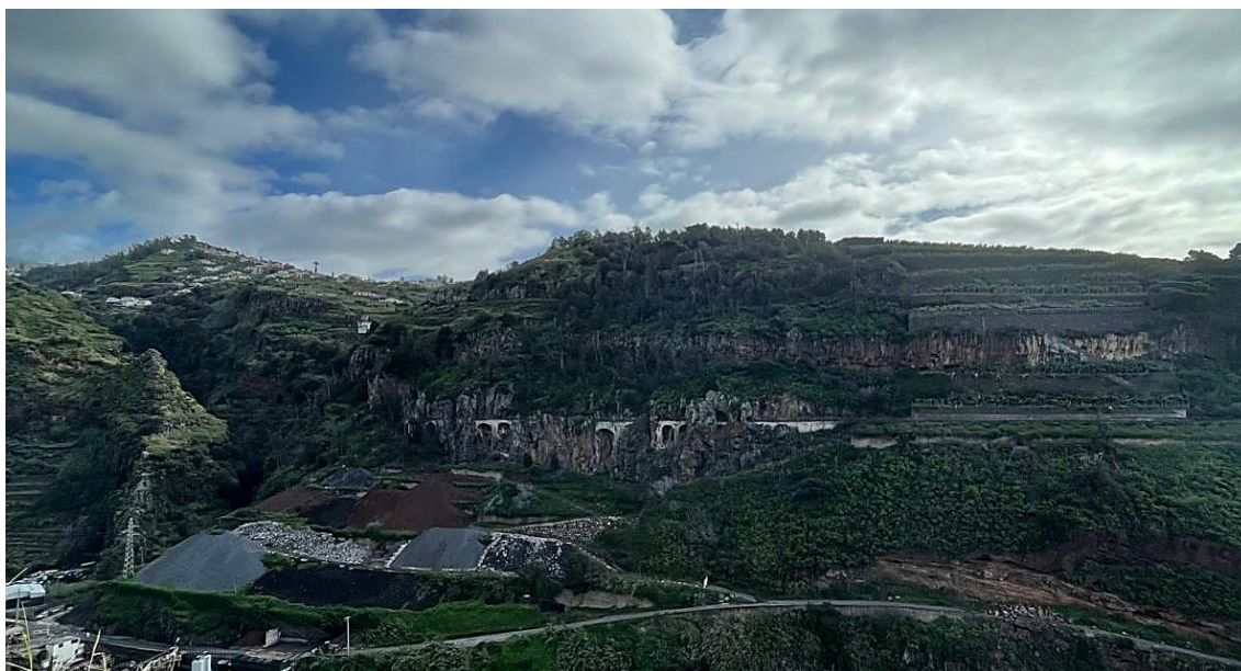
Figura 142: Aqueduto construído na escarpa Fonte: Da Autora
