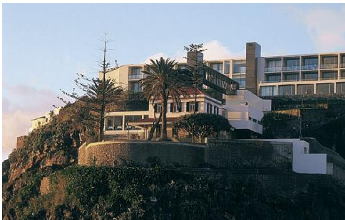
Figura 150: Fotografia atual da Estalagem da Ponta do Sol após intervenção Fonte: (Estalagem Ponta do Sol, s/d)
