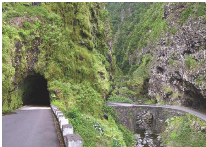
Figura 54: Túnel perfurado por estrada e a entender-se por uma ponte
