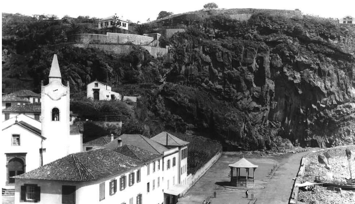
Figura 149: Fotografia antiga onde se observa a casa vernacular e o respetivo armazém Fonte: Arquivo e Biblioteca da Madeira
