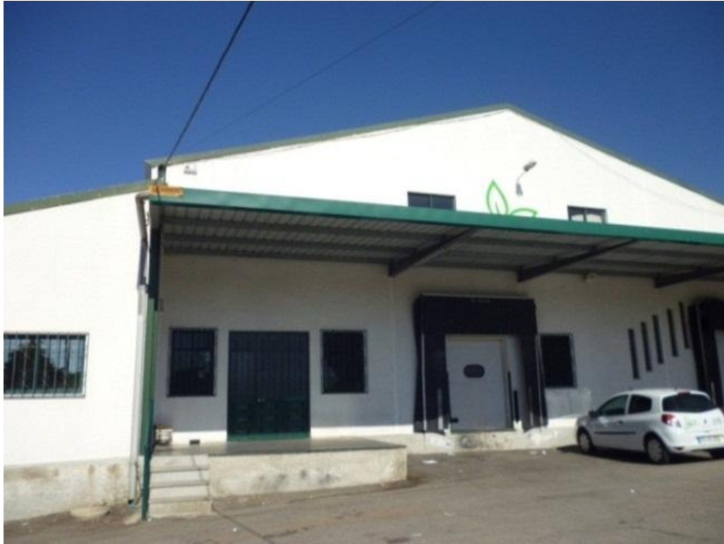
Figura 4.1 - Fachada principal da empresa protegida com telheiro em painel de sandwich .
