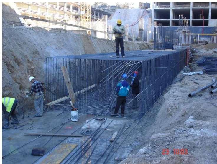
Figura 35 - Montagem de armadura de sapata corrida assente sobre solo residual
