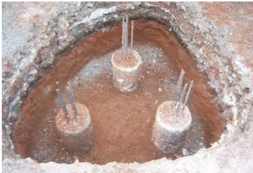
Figura 33 - Escavação de blocos de fundação
