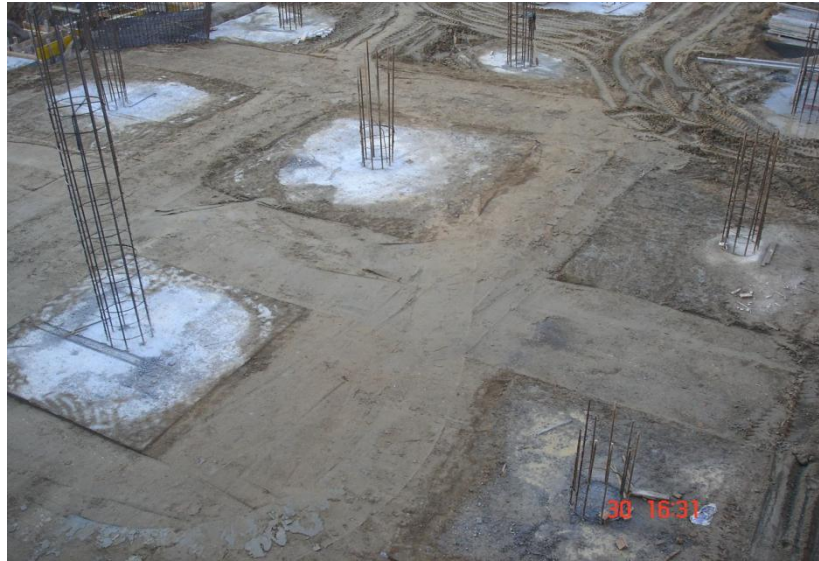
Figura 32 - Sapatas isoladas assentes sobre solo residual
