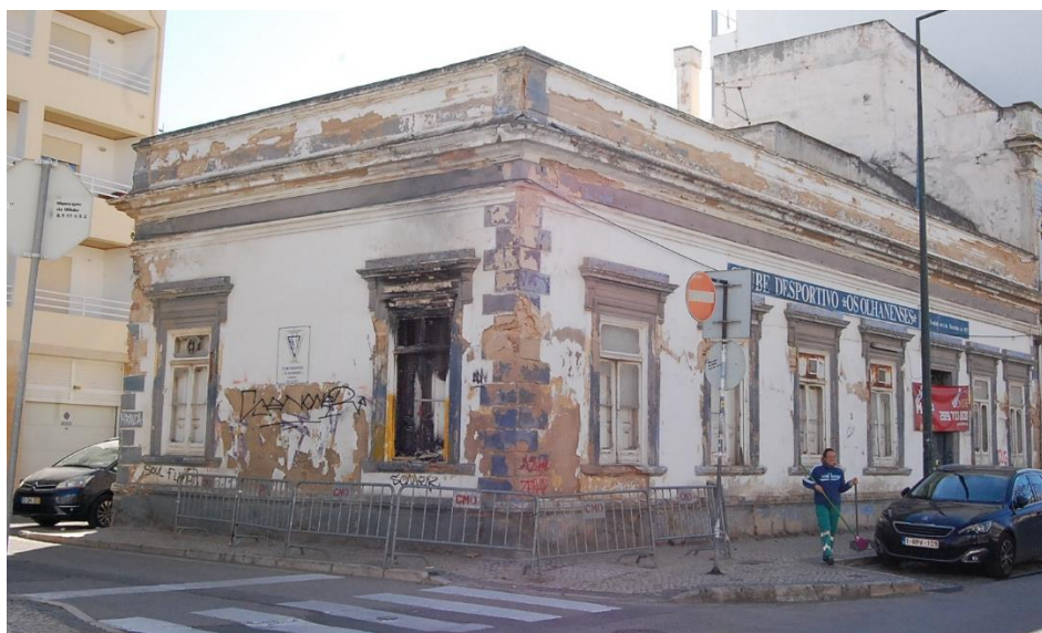
Figura 110 - Edifício histórico recentemente demolido.
