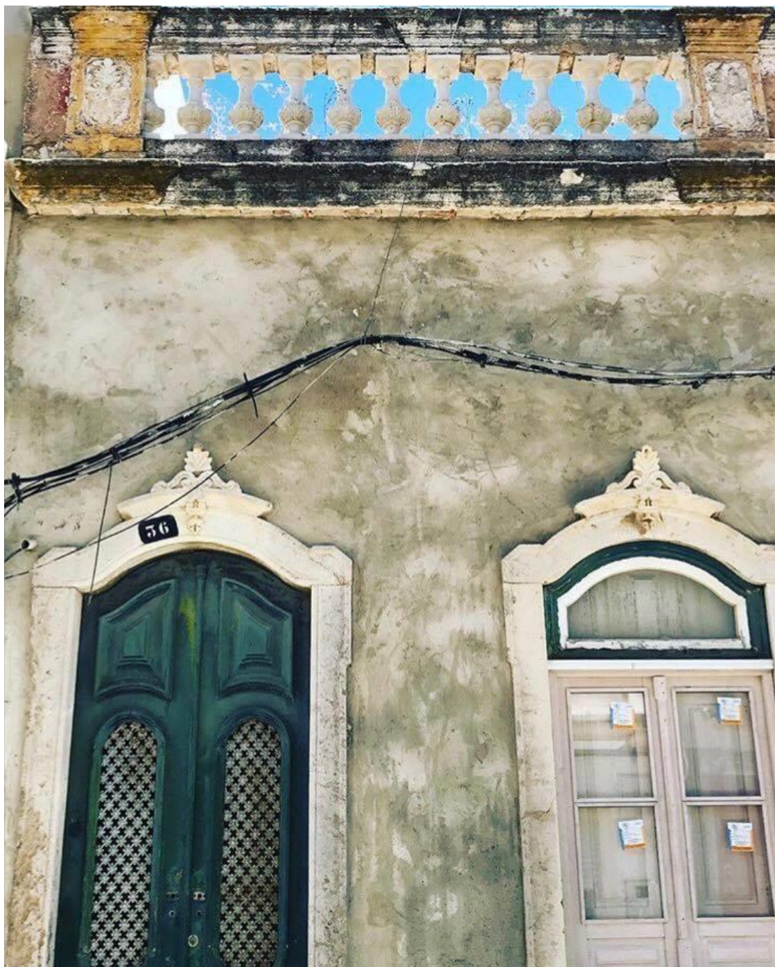
Figura 115 - Fachada de habitação típica Olhanense, em processo de restauro.
