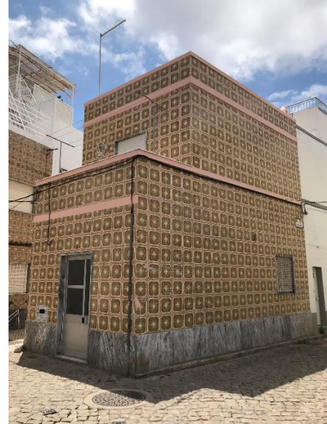
Figura 112 - A mesma habitação após sofrer transformação para o estilo arquitectónico de estilo "cubista" e ser revestida a azulejo.
