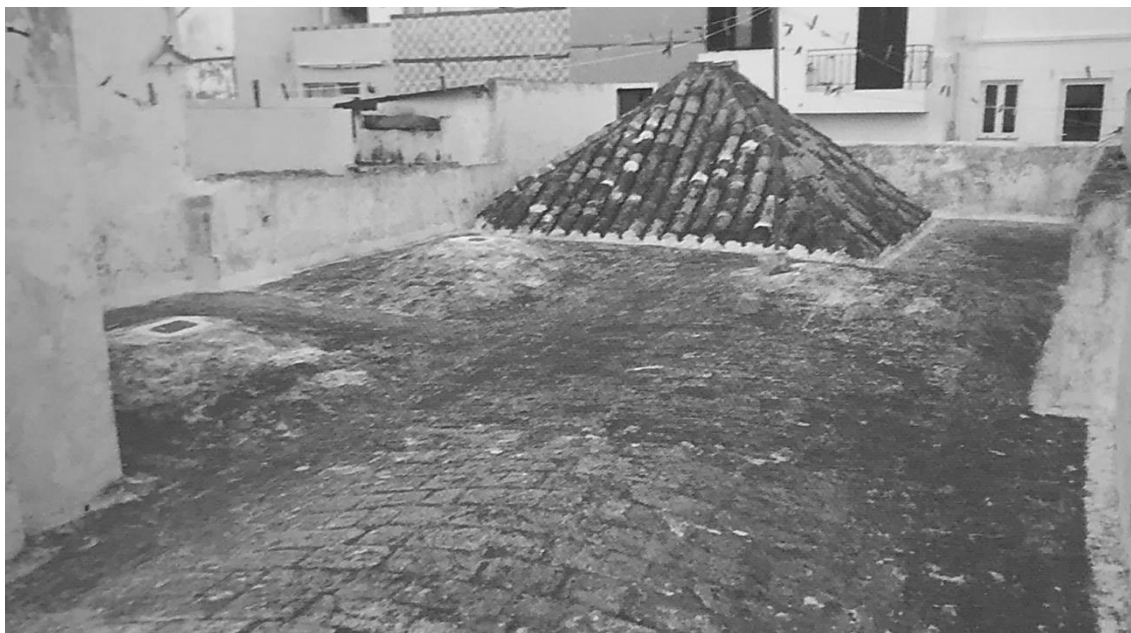
Figura 101 - Cobertura plana em açoteia com pequeno telhado de tesouro.
