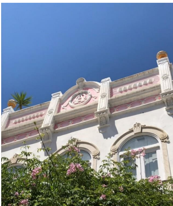
Figura 19. Casa Urbana na cidade de Olhão com platibanda ornamentada.
