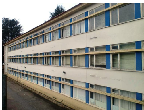
Fig. 6: Exterior do Edifício de aulas da Escola Básica Grão Vasco
