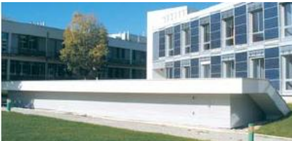
Figura 104 - Vista do Edifício Solar XXI – poço de admissão do ar [Fonte: INETI, 2009]
