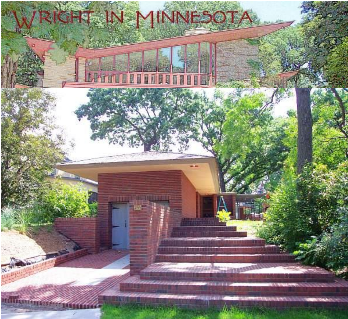
Figura 80 - Frank Lloyd Wright: Casa Malcolm Willey, Minneapolis, Minnesota, EUA. Vistas.
