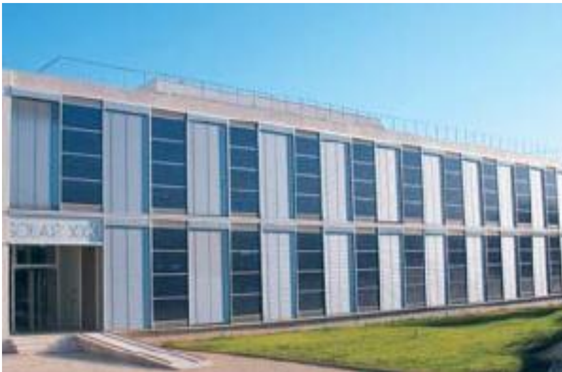
Figura 98 - Vista do Edifício Solar XXI – estores fechados/verão [Fonte: INETI, 2009]
