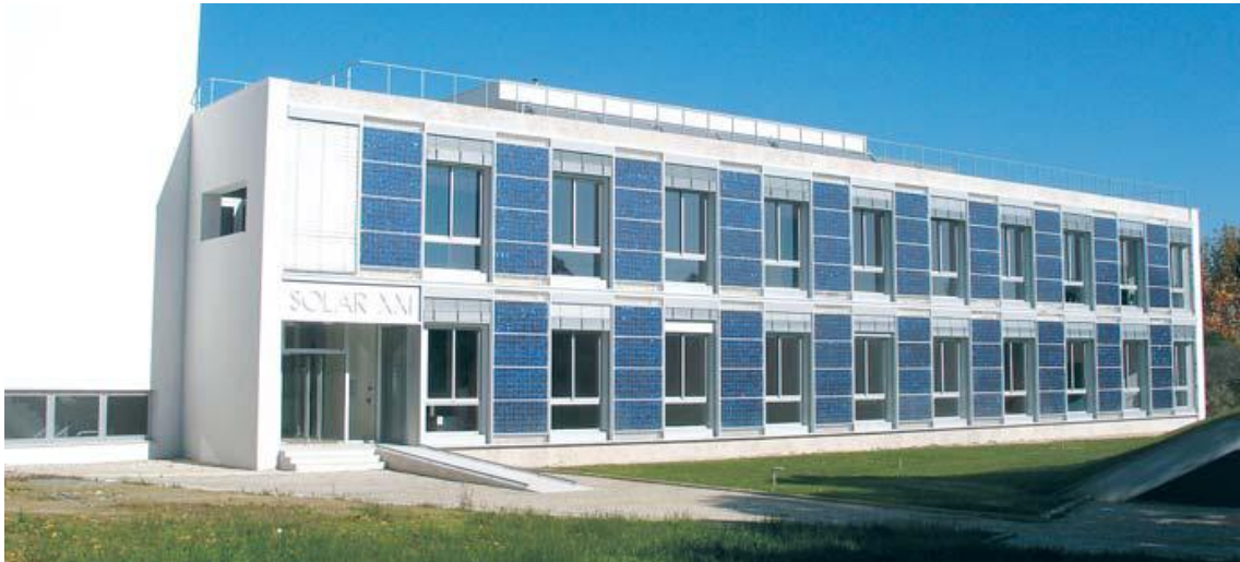
Figura 94 - Vista do Edifício Solar XXI fachada sul/poente [Fonte: INETI, 2009]
