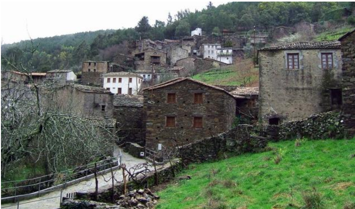
Figura 84 – Alvenaria de pedra, casas típicas da Freguesia do Candal – Lousã. [Fonte: www.olhares.com , 2009]
