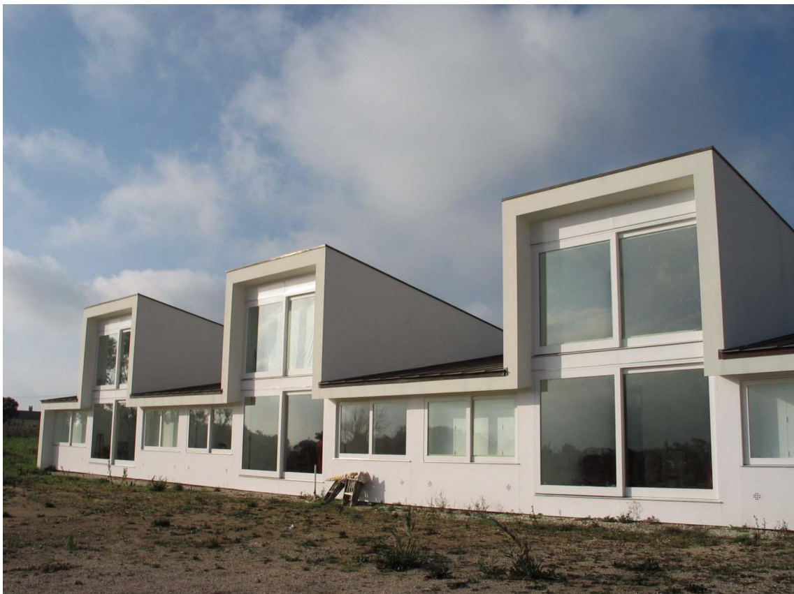
Figura 106 - Fachada Sul das Moradias de Janas [Fonte: DGE, 2007]
