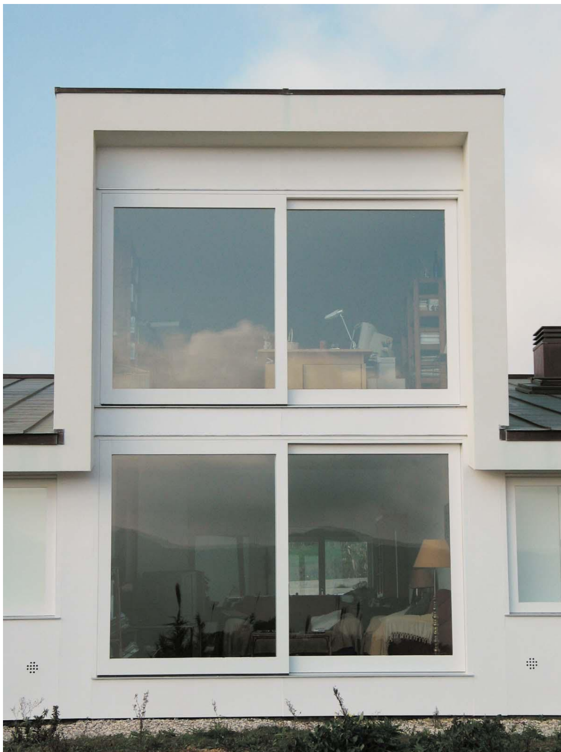
Figura 109 - Vãos envidraçados da sala na fachada Sul [Fonte: DGE, 2007]
