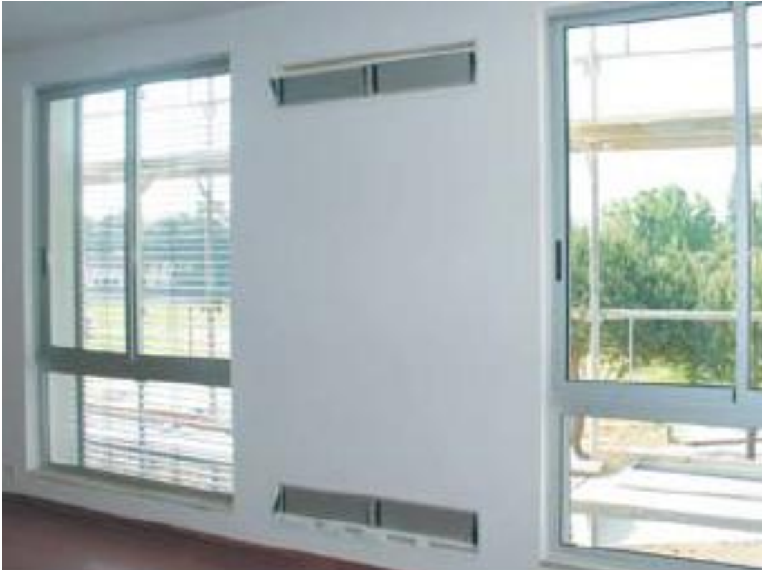
Figura 101 - Vista do Edifício Solar XXI – aberturas de ventilação [Fonte: INETI, 2009]
