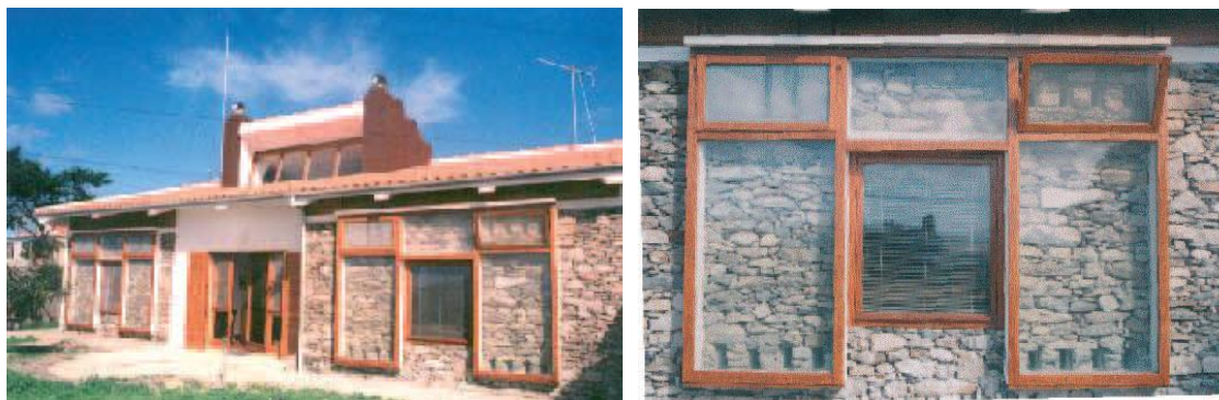
Figura 63, 64 - A casa Schäfer Porto Santo - Paredes de Trombe - Arqt.º Günter Ludwig – principal e porm. janela [Fonte: Gonçalves INETI. 1997]
