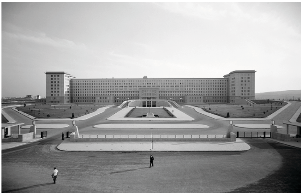
Fig. 59 - Fachada principal do Hospital Central de Santa Maria (1940-1953) em Lisboa
