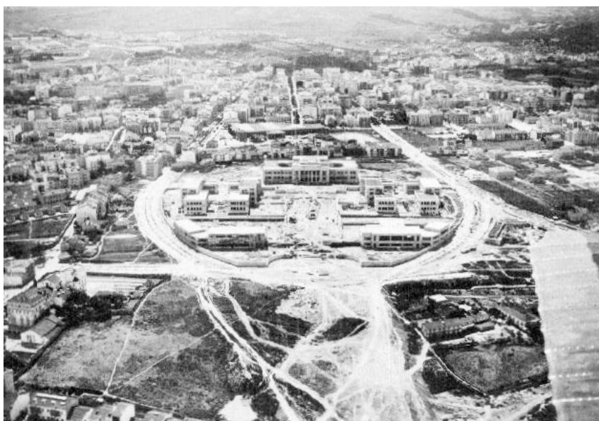
Fig. 37 - Panorama do IST em construção - 1934.
