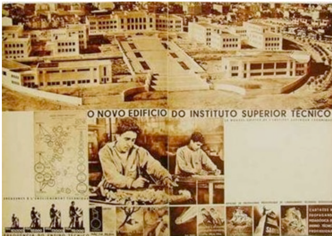
Fig. 28 - "O novo edifício do Instituto Superior Técnico" - in "Portugal 1934" pág.12 - 13.
