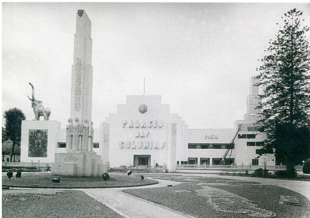
Fig. 75 - Palácio de Cristal - Fachada transformado para a I Exposição Colonial Portuguesa - Porto 1934.
