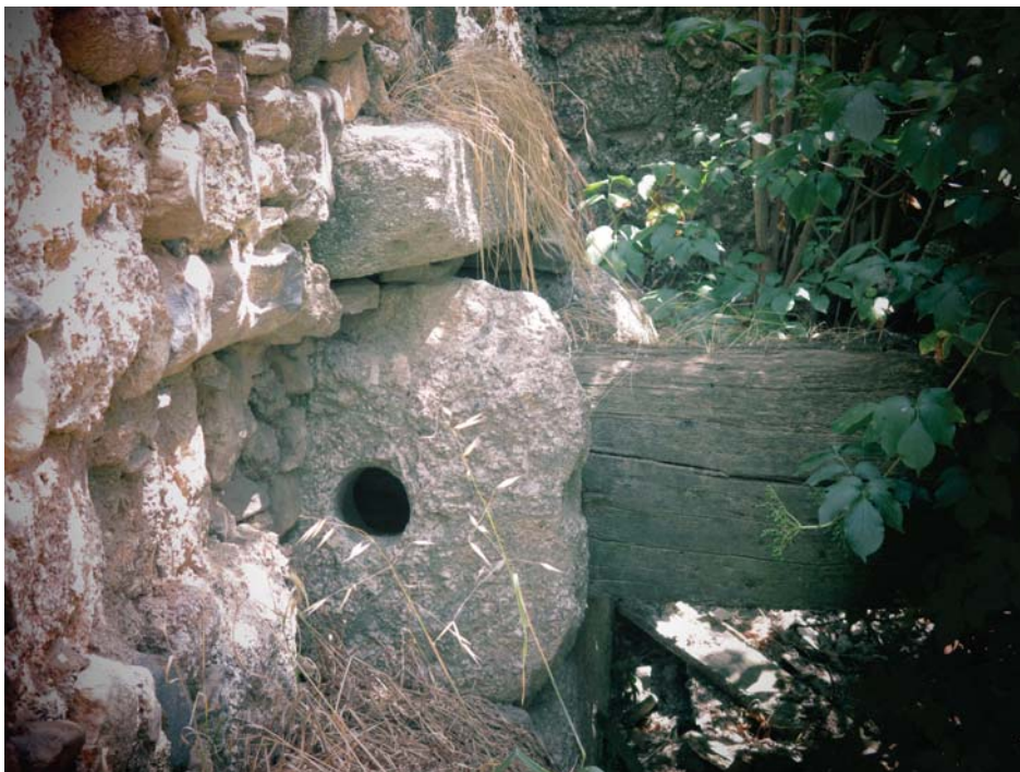
Figura 109 - Pormenor de um elemento do lagar de vinho. Fonte: Imagem do autor
