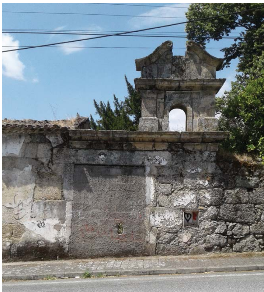
Figura 100 - Campanário. Fonte: Imagem do autor.
