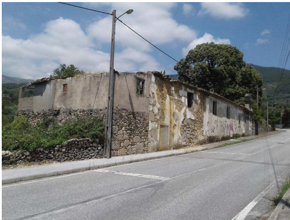
Figura 99 - Fachada Principal. Fonte: Imagem do autor.
