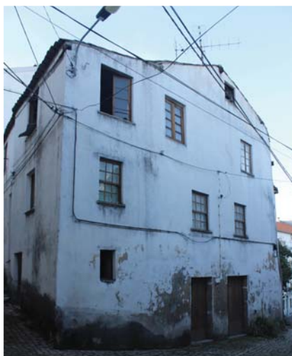
Figura 52 - Casa destinada ao Centro de Atividades. Fonte: Imagem do autor.
