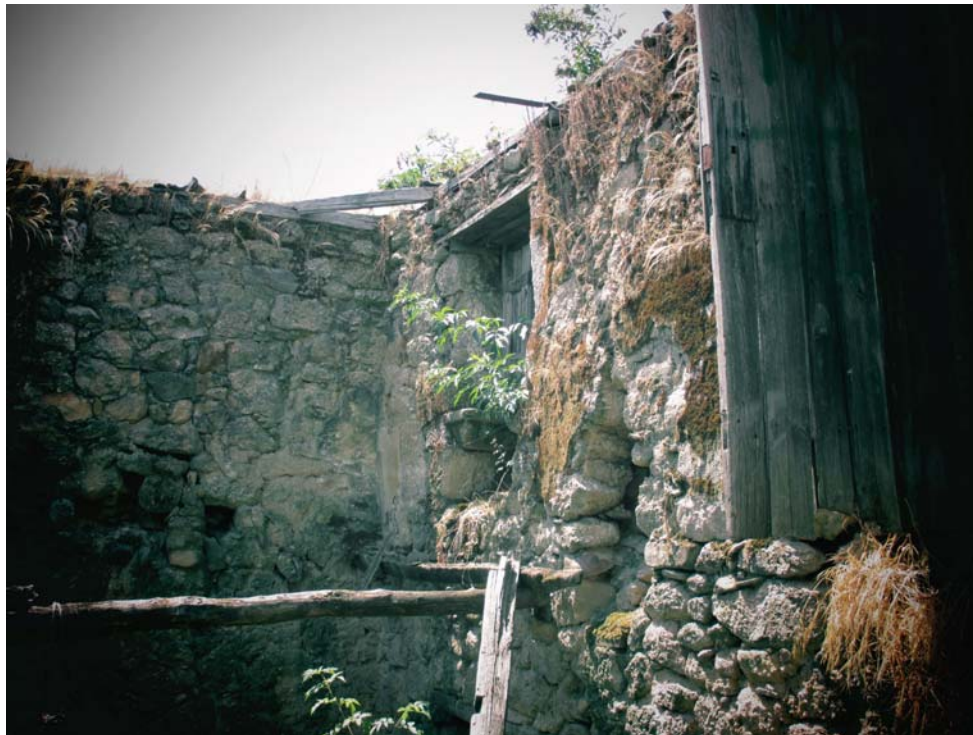
Figura 107 - Imagem do interior do edifício. Fonte: Imagem do autor.
