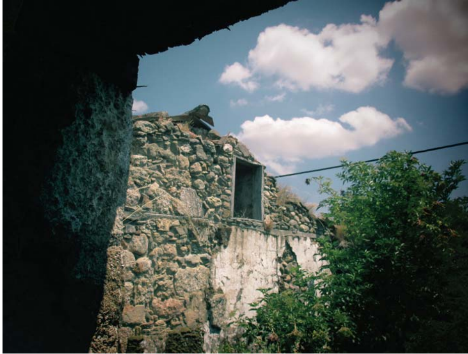
Figura 108 - Imagem do interior do edifício 1. Fonte: Imagem do autor.
