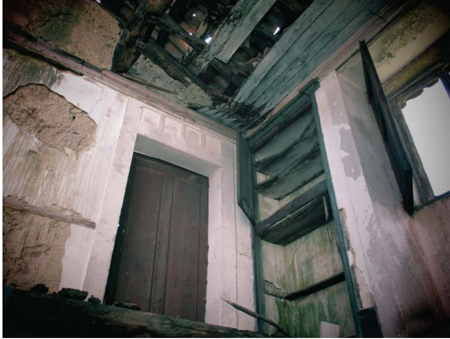
Figura 111 - Fotografia do Interior do edifício 1. Fonte: Imagem do autor
