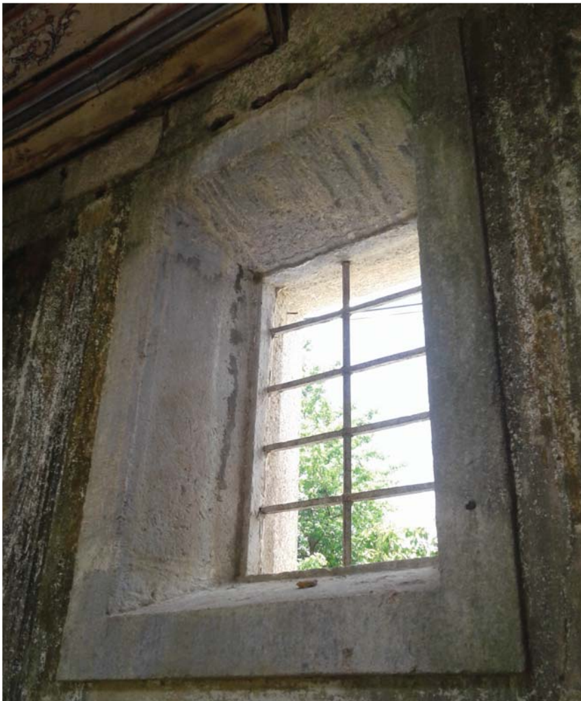
Figura 114 - Janela da Capela da Quinta de S. João. Fonte: Imagem do autor
