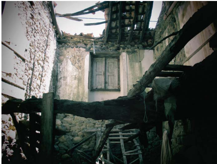
Figura 112 - Fotografia do interior do edifício 1. Fonte: Imagem do autor
