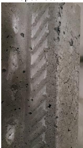
Desmonte do CP.1.H60 - betão
