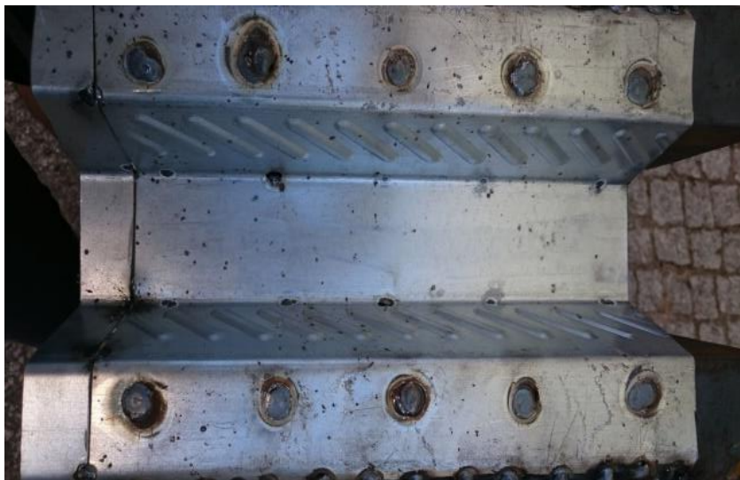
Figura 82 - Corpos de prova após construção da parte metálica
