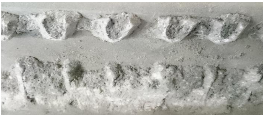
Figura 108 - Esmagamento do betão na interface (aço) - CP.4.NSP
