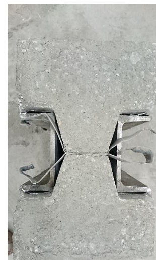
Figura 88 - Remoção de chapa de cofragem
