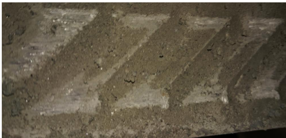
Figura 99 - Esmagamento do betão na interface (betão) - CP.2.H60
