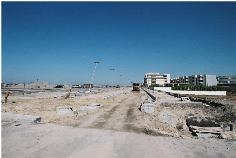
Fig. 151 | Trabalhos de colocação das bases, 2003
