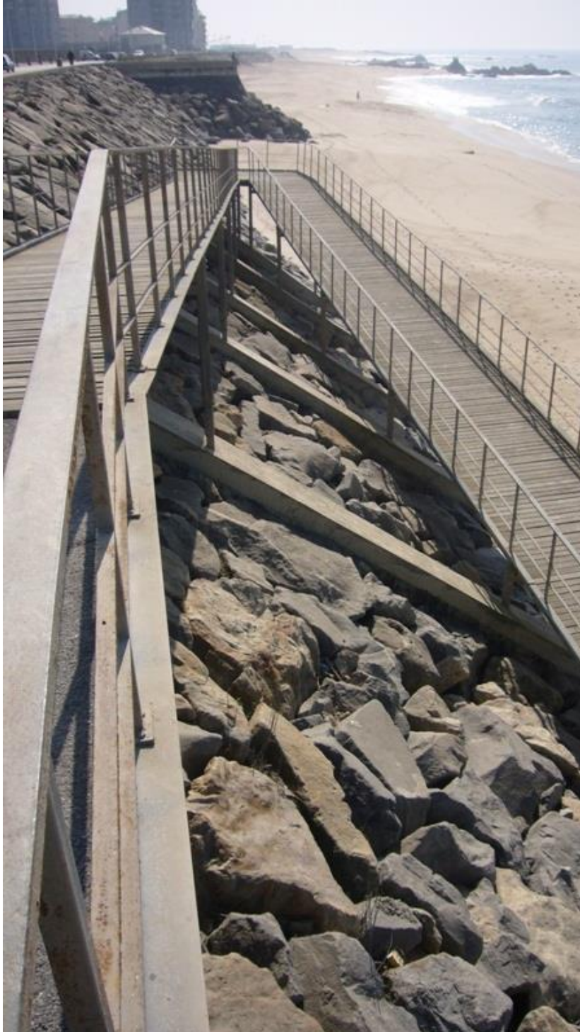
Fig. 106 | Colunas de JET sob a capa de enrocamento, 2006
