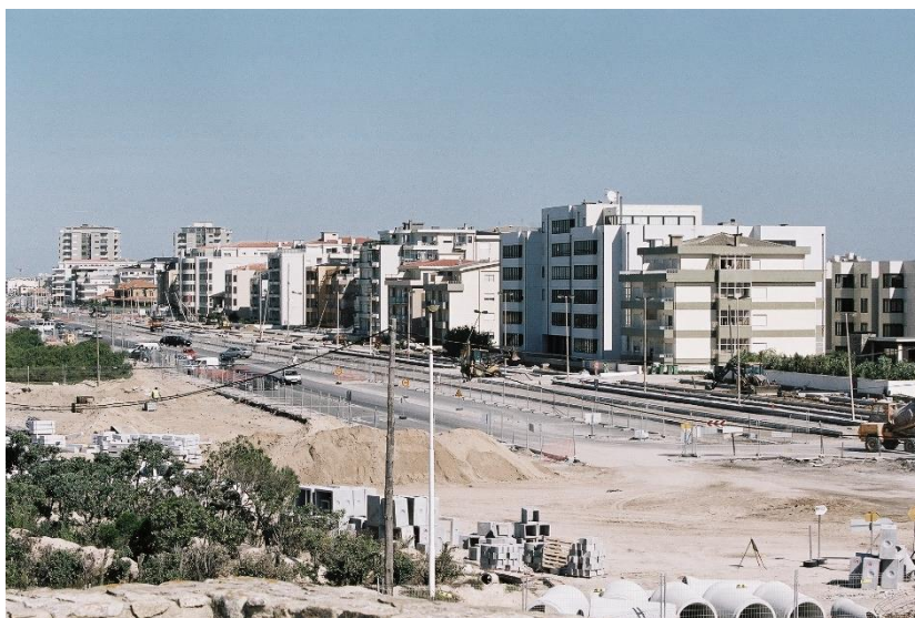
Fig. 147 | Trabalhos de abertura das caixas de pavimentos, 2003
