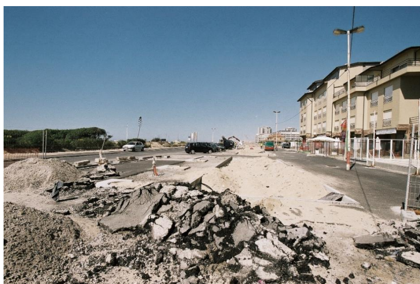
Fig. 148 | Trabalhos de escavações para remoção de solos, 2003
