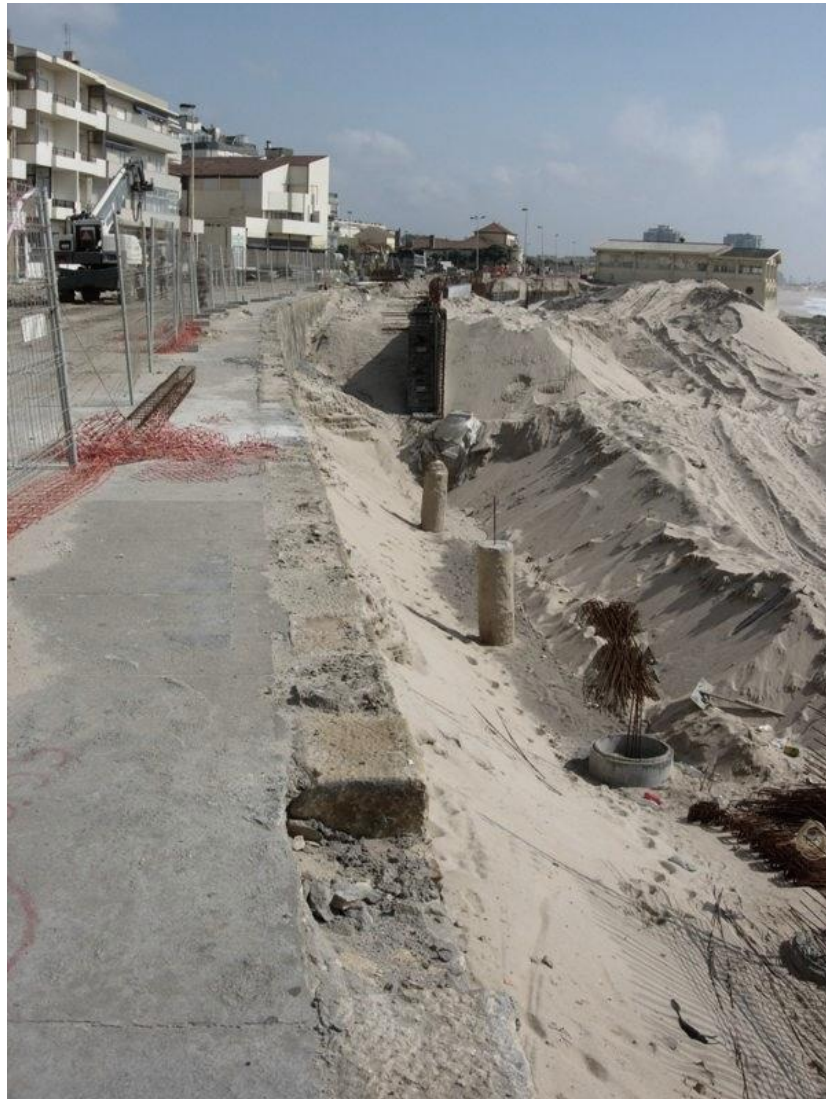
Fig. 146 | Colunas de JET GROUTING com micro estacas no seu interior,
