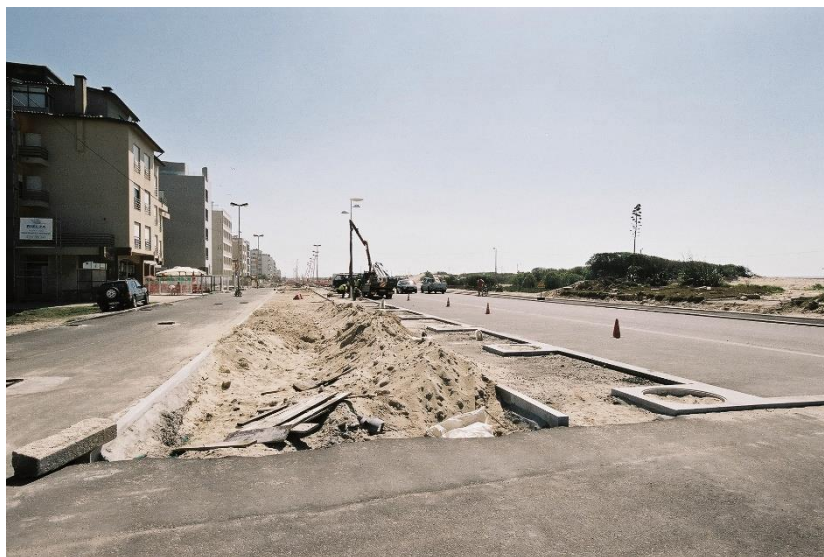
Fig. 152 | Trabalhos de aplicação dos pavimentos, 2003
