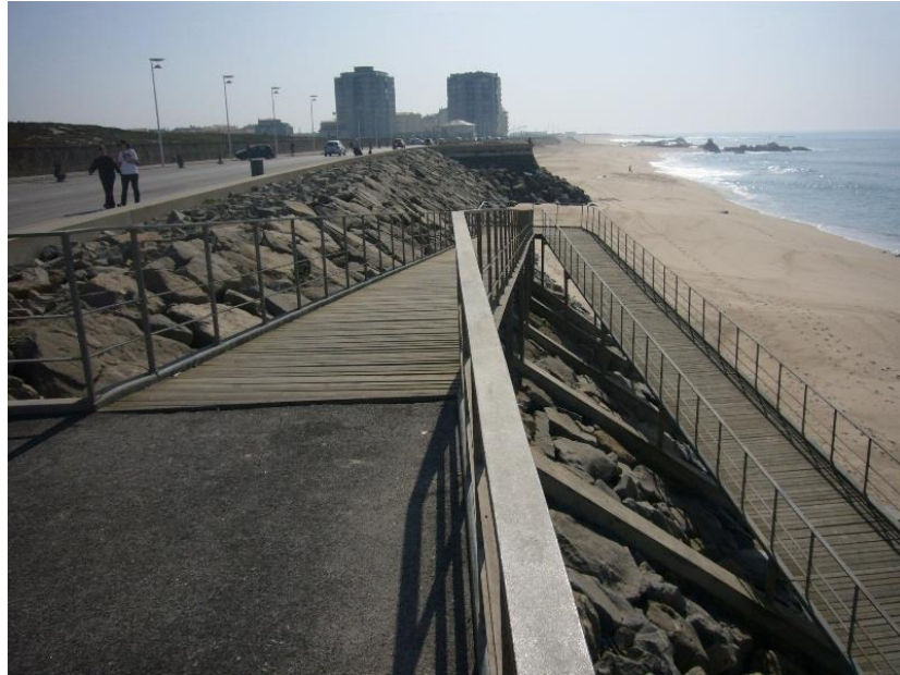
Fig. 107 | Início da Rampa de acesso na Laje, 2006
