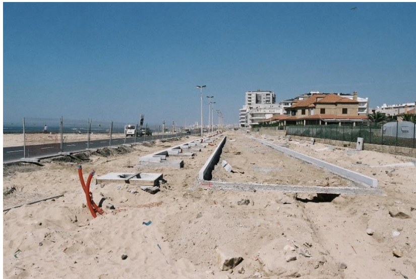
Fig. 150 | Trabalhos de reposição de solo, 2003
