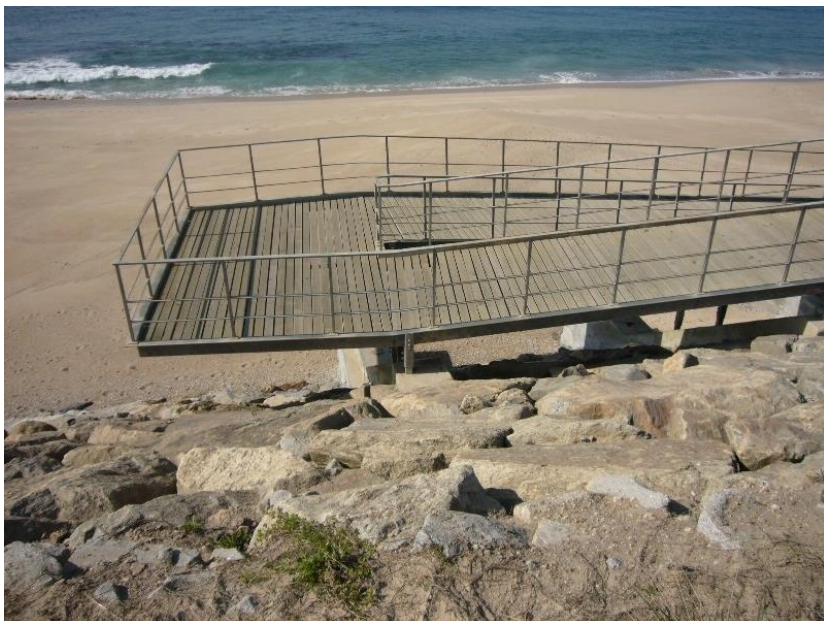
Fig. 105 | Rampa em Estrutura metálica com estrados de Madeira, 2006
