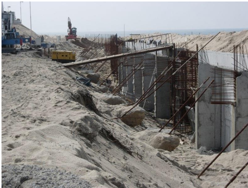
Fig. 144 | Tímpanos afundados diretamente em rocha, 2003
