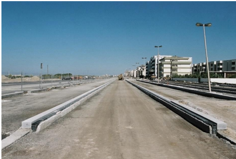
Fig. 156 | Trabalhos de aplicação das Caleiras
