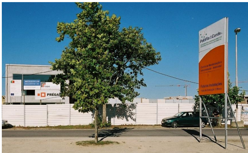
Fig. 51 | Início das obras para o Centro de Monotorização e Interpretação ambiental, 2005
