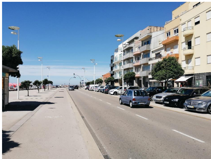
Fig. 87 | Área 3 – Sentido Norte, 2020
