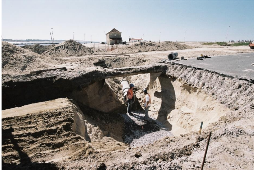
Fig. 149 | Trabalhos de abertura dos cabouços para fundações, 2003
