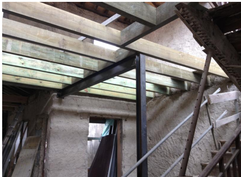
Fotografia 12: Reforço estrutural através de um suporte em estrutura metálica.
