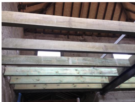
Fotografia 10: Reforço estrutural através de vigotas em madeira.
