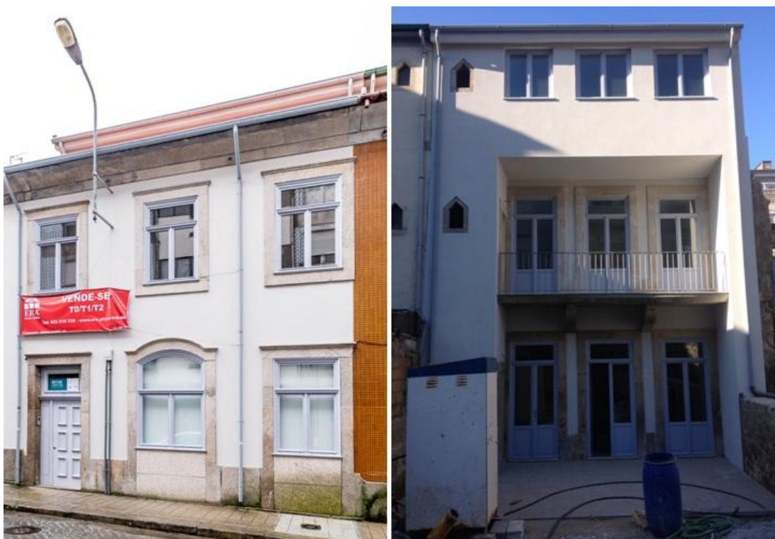
Fotografia 35: Fachadas, principal e traseira, reabilitadas.
