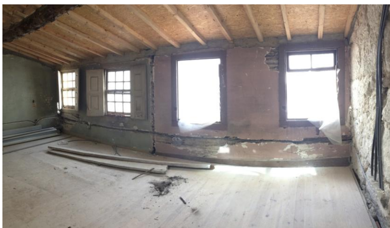
Fotografia 14: Fase da criação e colocação de infraestruturas.
