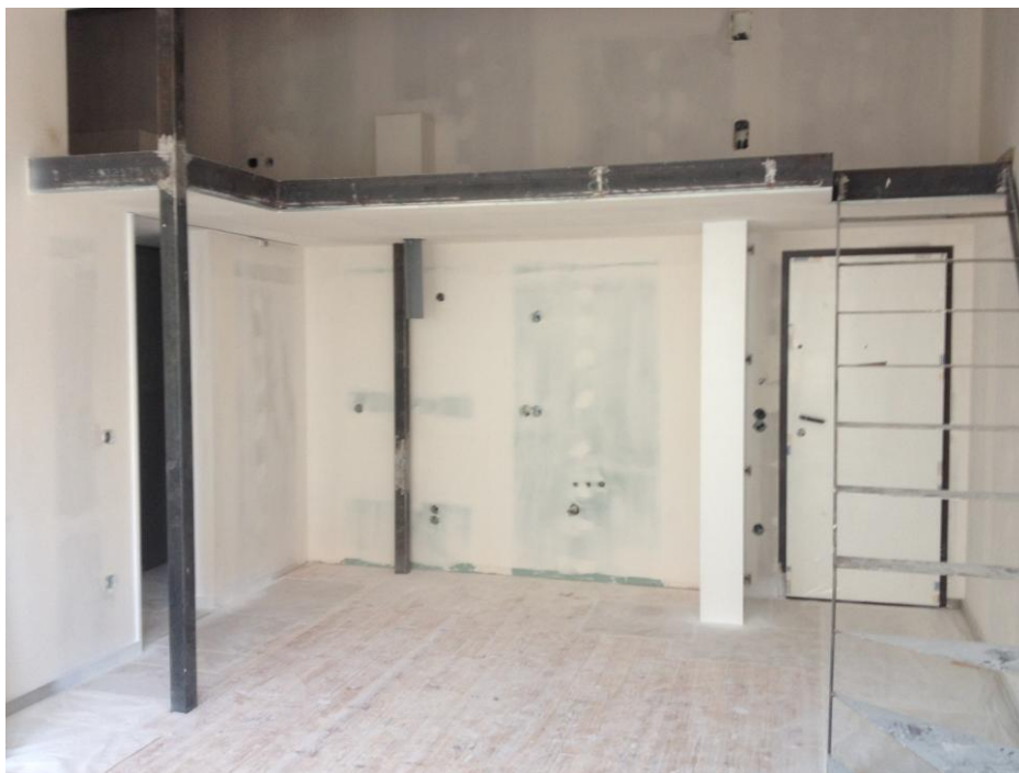
Fotografia 21: Mezanino e outros materiais de acabamentos.
