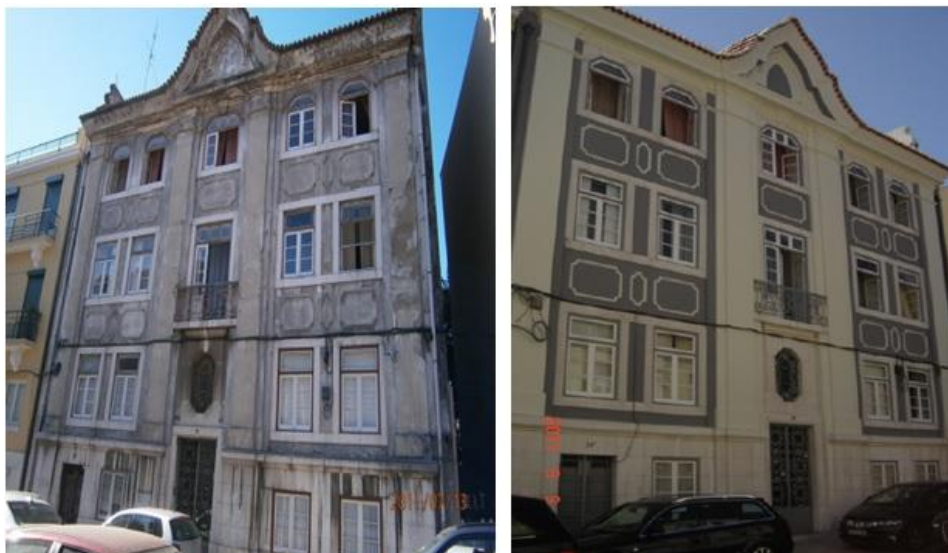
Figura 8: Edifício antes e depois de ser reabilitado (Diário Económico, 2011).
