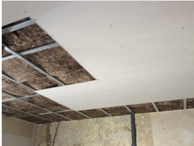
Fotografia 16: Revestimento do teto em gesso cartonado.
