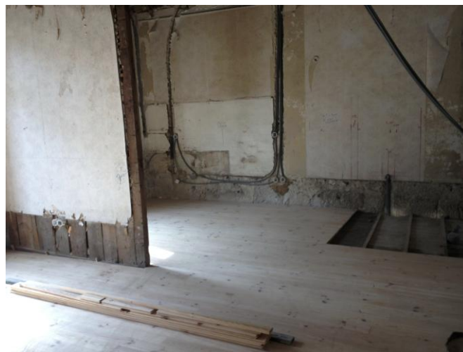
Fotografia 17: Colocação de infraestruturas e revestimentos interiores.
