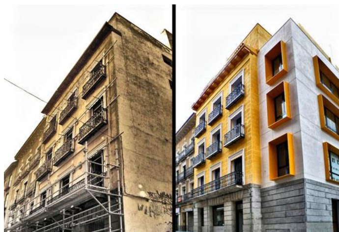
Figura 6: Edifício urbano antes e depois de ser reabilitado (euroflat).
