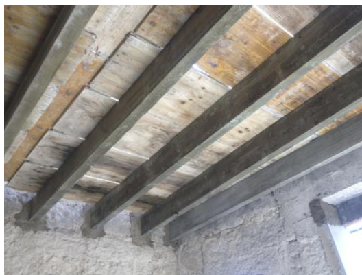
Fotografia 9: Reforço estrutural através de vigotas em madeira.
