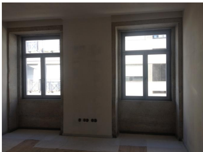
Fotografia 23: Fase de acabamentos.
