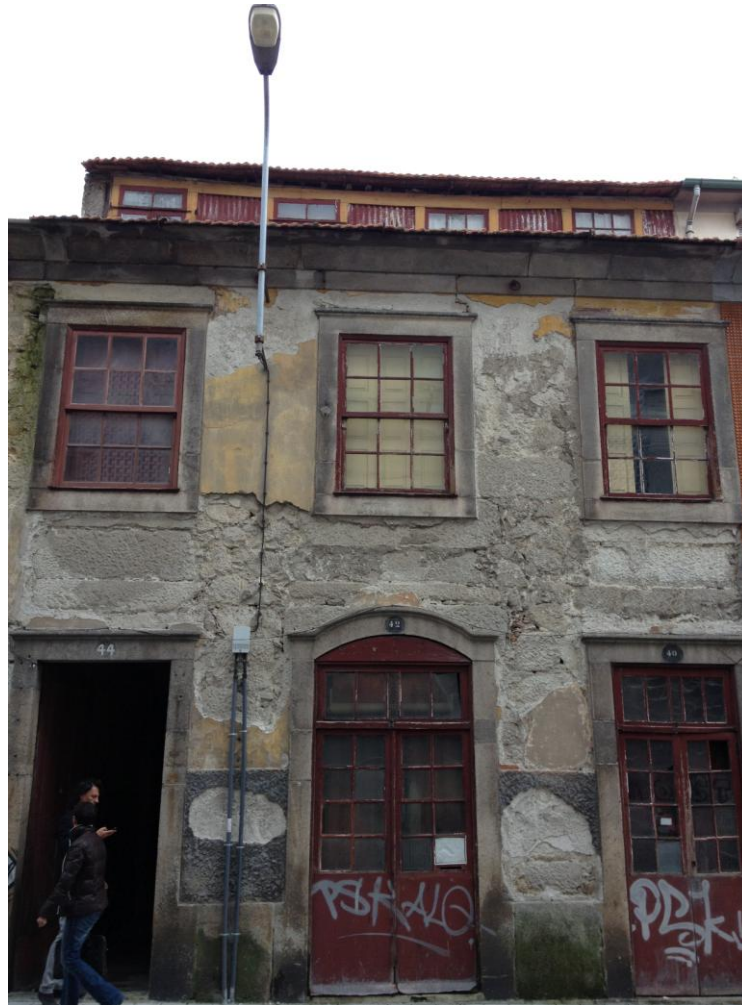
Fotografia 1: Fachada do edifício no momento em que é entregue à empresa.
