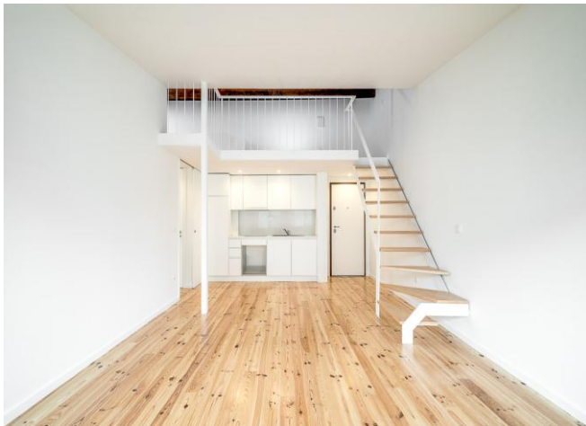
Fotografia 25: Solução final da instalação de um mezanino em estrutura metálica, no T1 das “ Águas furtadas”.
