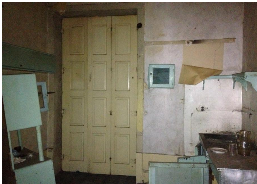
Fotografia 5: Interior do edifício prestes a ser demolido.
