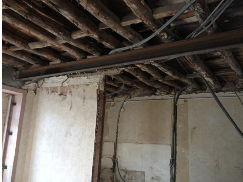
Fotografia 11: Perfil em estrutura metálica a reforçar a estrutura em madeira.
