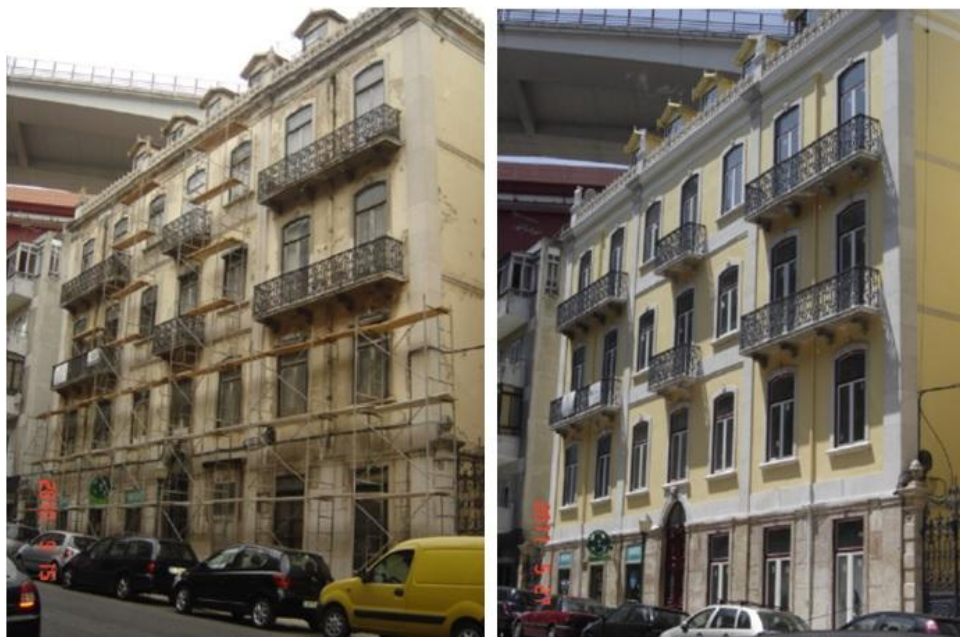
Figura 7: Edifício antes e depois de ser reabilitado (Diário Económico, 2011).
