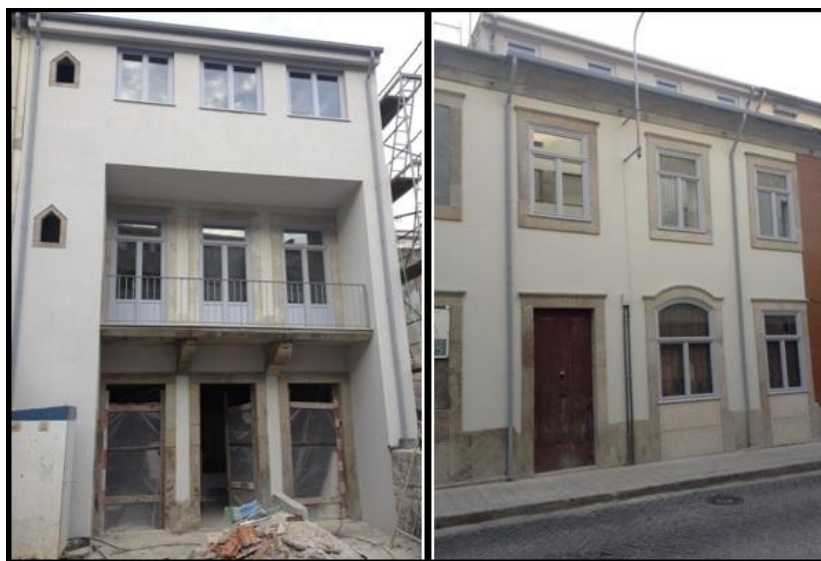
Fotografia 24: Fase final da obra - fachada traseira e principal.
