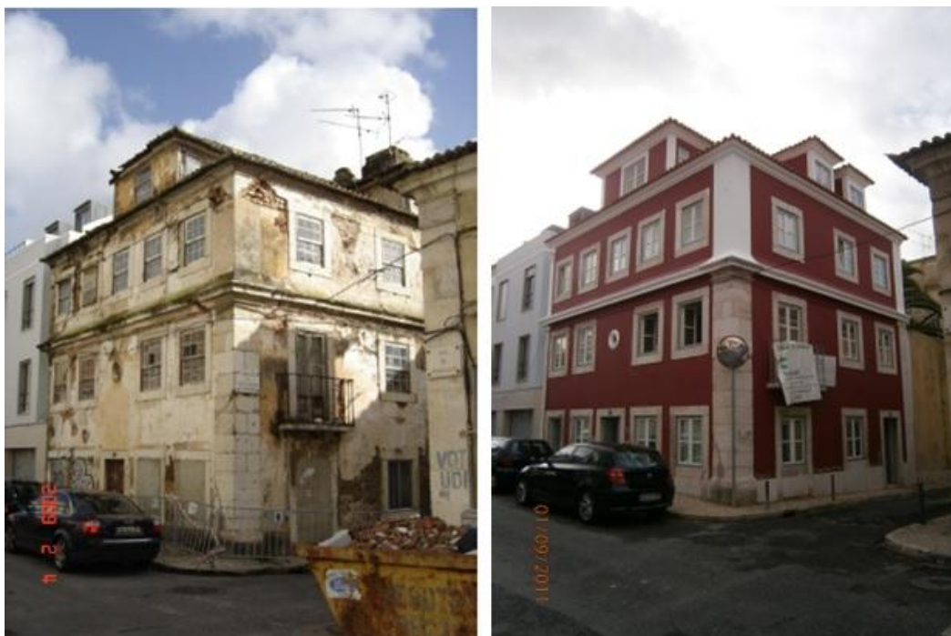
Figura 9: Edifício antes e depois de ser reabilitado (Diário Económico, 2011).
