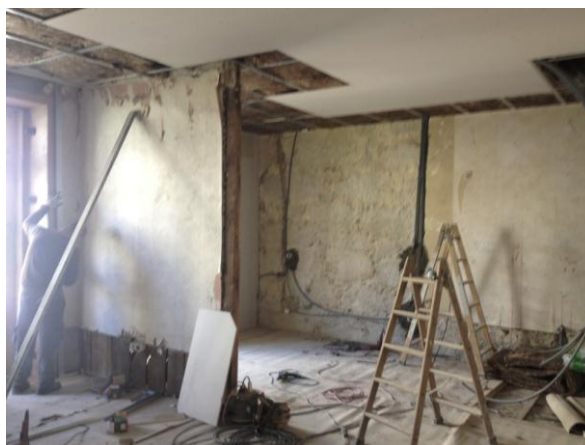
Fotografia 15: Colocação de infraestruturas e revestimentos interiores.
