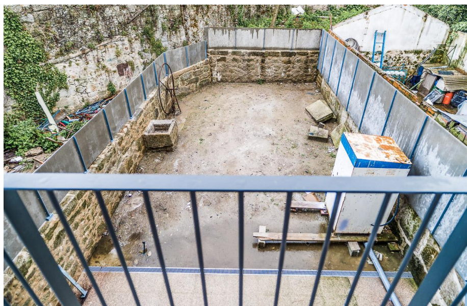
Fotografia 34: Guarda metálica da varanda do piso 1 com vista para o terreno exterior.
