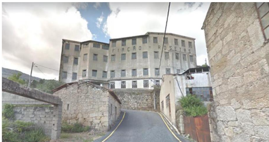
Figura 14 – Fachada da fábrica Fiação Roseta.
