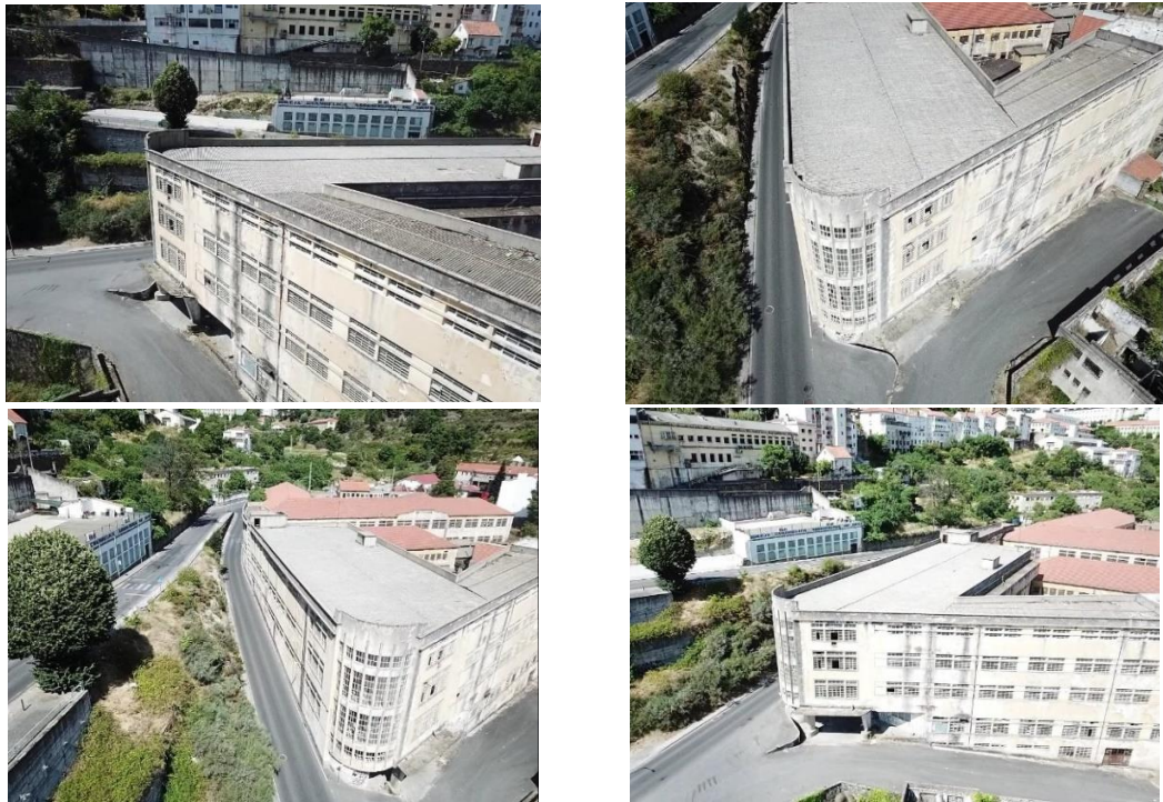
Figura 67 – Conjunto fotografias da Cobertura da “Nova Penteação” tiradas por Drone
