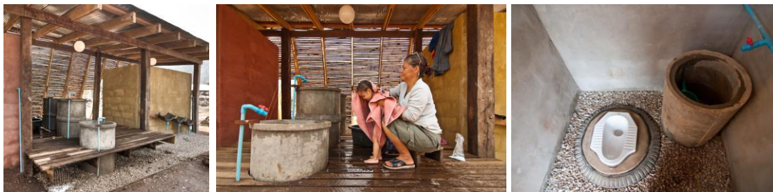
Fig. 47 -“Safe Heaven Bathhouse”, fotografias e pormenores do interior. Uma vez que existiam alguns problemas com o sistema de esgoto, a equipa criou um sistema de pavimento de cascalho e madeira, que facilmente se mantém seco e limpo, e usando camadas de cascalho e pedra para drenar todas as áreas molhadas.
