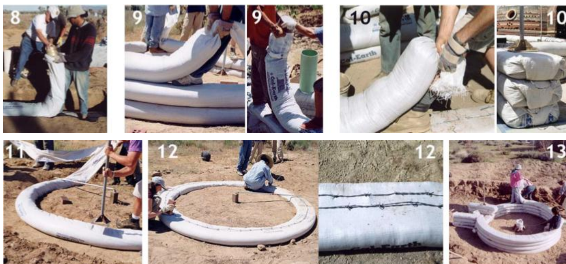
Fig. 41 - “Super Adobe”, fotografias da construção.
