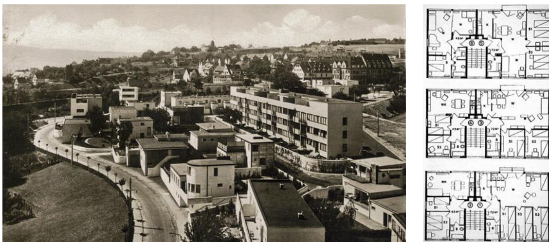
Figura 3.18 - Edifícios de apartamento, Mies van der Rohe, Stuttgart, 1927.
