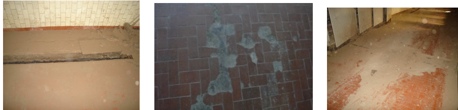
Figura 41 – exemplo de imagens de pavimento da unidade fabril.
