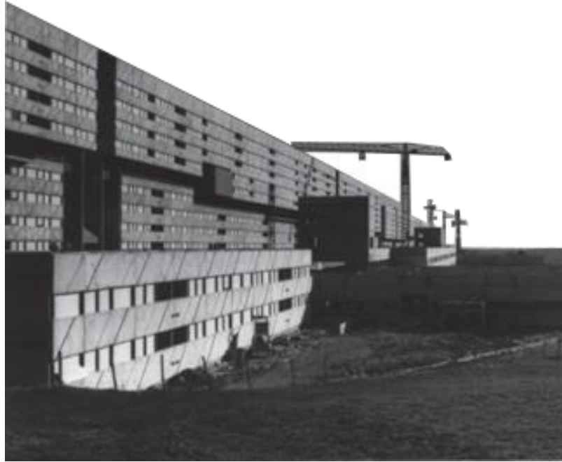
Figura 15. Construção do Corviale a partir de: (Riso, 2017)
