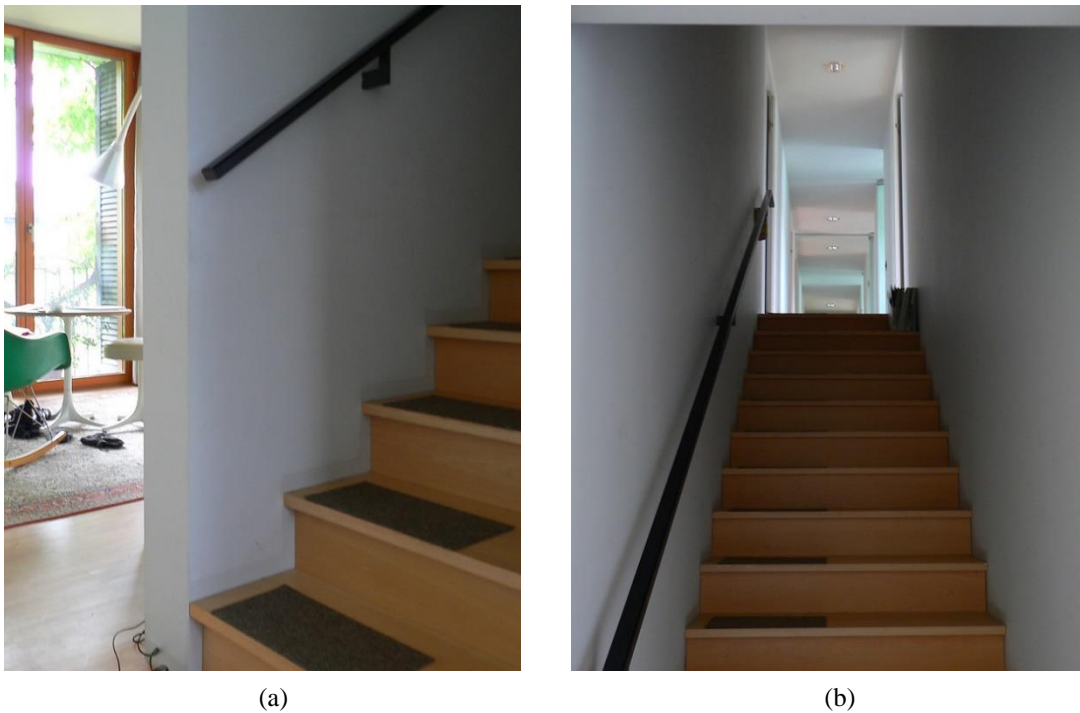
Figura 71 – Vista das escadas que dão acesso ao piso superior de um dos apartamentos do edifício sul (Fonte: Sandro Maggi).
