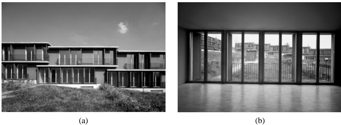
Figura 62 – Vistas das aberturas do Edif cio norte: (a) exterior; e (b) interior (Fonte: Christian Richters).
