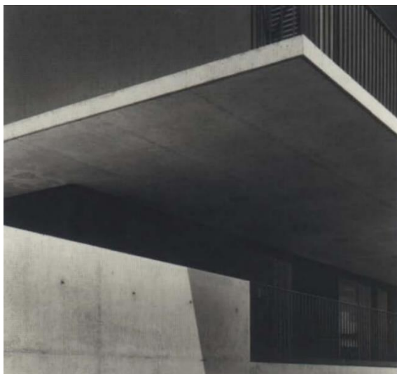
Figura 75 – Fotografia onde é perceptível a utilização do betão aparente (Fonte: Hélène Binet).
