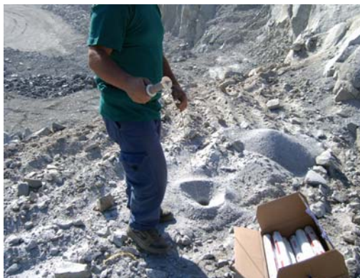
Figura 14 – Carregamento da bancada
