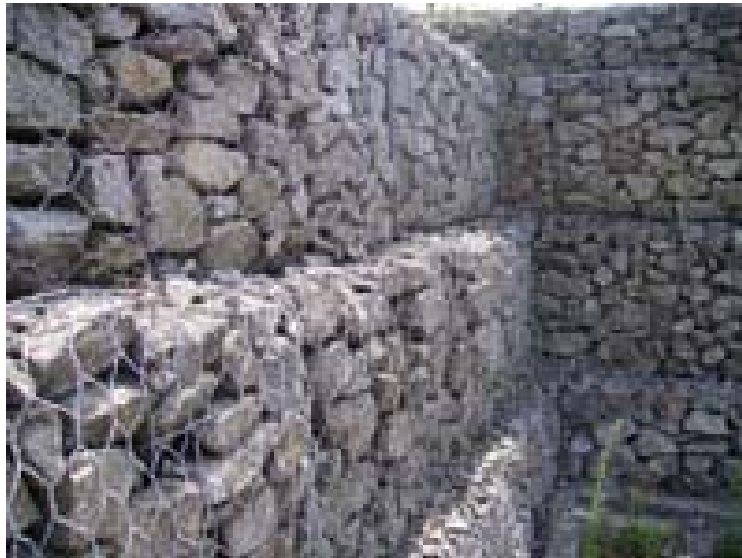
Figura 28 – Muro de Contenção em Rachão
